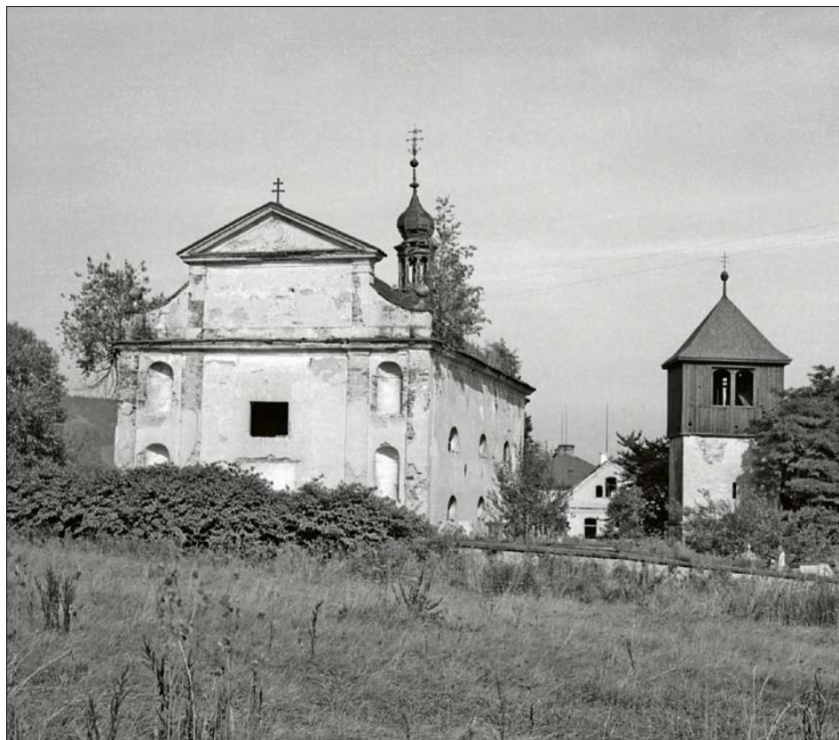
Obr. 12: Kostel a zvonice v Merbolticích (okres Děčín), 60. léta 20. století (Oblastní muzeum Děčín, přír. č. 34477).
