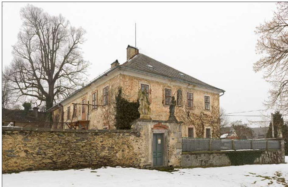
Obr. 10: Areál fary ve Valkeřicích – farní budova a ohradní zeď s branou, současný stav (foto J. Peer, 2021).
