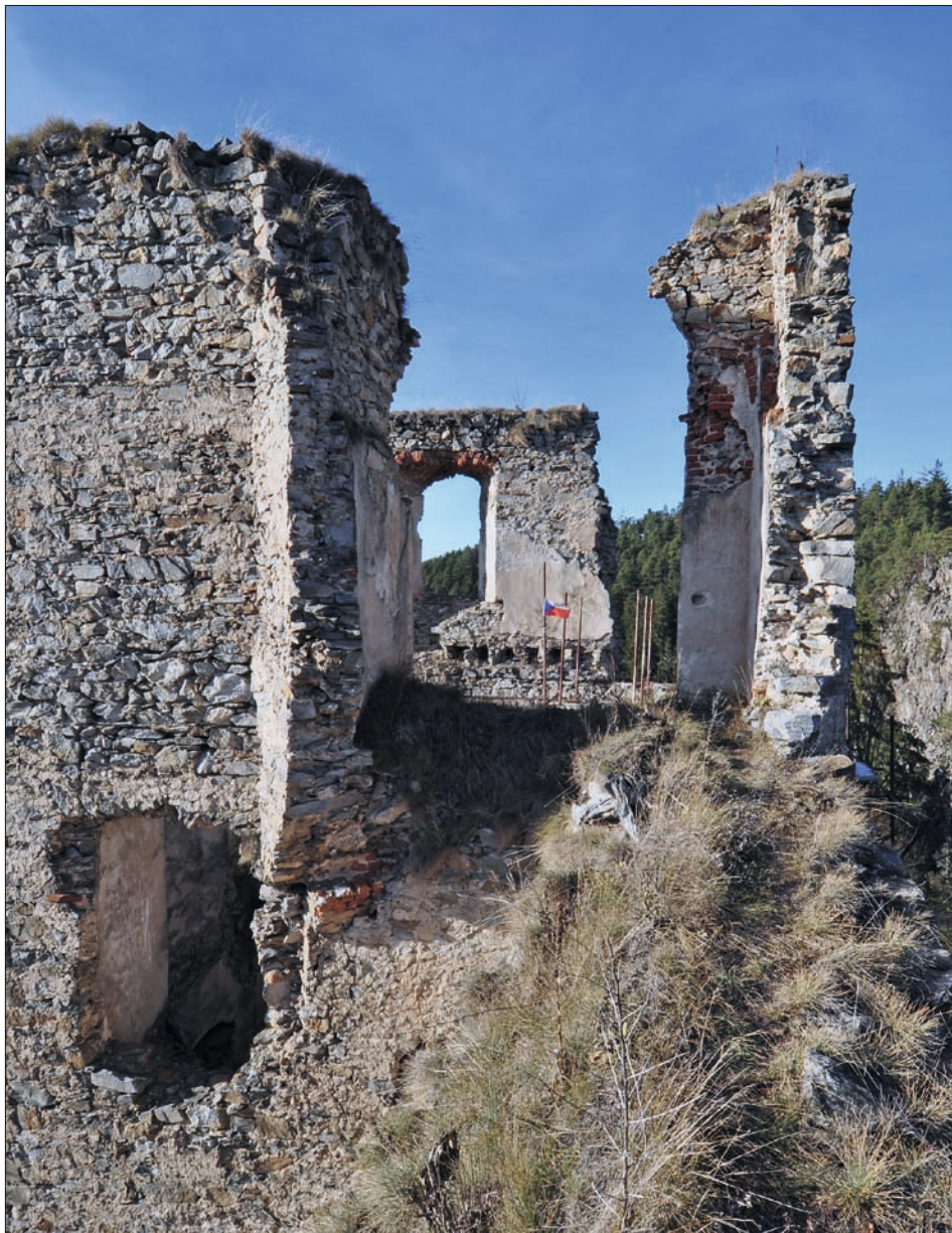
Obr. 51: Dívčí Kámen, pohled z koruny severní spojovací zdi směrem ke zřícenému kaplovému arkýři. V popředí zbytky tenkých zdí arkýře a náběhy triumfálního oblouku, v pozadí část západní zdi sálu s jedním oknem (srov. obr. 31–33, 38, 48), stav 2017.
