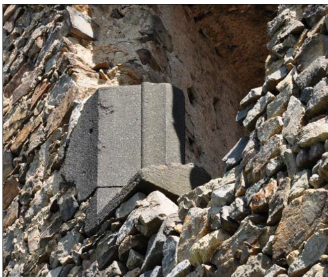
Obr. 74: Helfenburk, fragment ostění jižního okna v západní obytné části paláce, dochovaný in situ (srov. obr. 72 a 73). Zřetelná je profilace stojky nad parapetním dílem, stav 2017.
