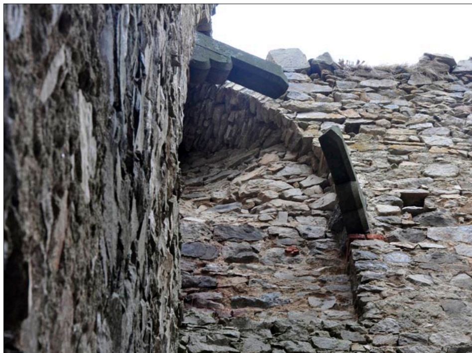
Obr. 81: Helfenburk, zbytky krbu v jiho-východním koutě severní místnosti 1. patra západní obytné části paláce. Při pohledu z přízemí vidíme dvě natočené tesané konzoly pláště dýmníku, zahýbajícího do komína, který byl společný s komínem kamen v jižní prostře, stav 2015.
