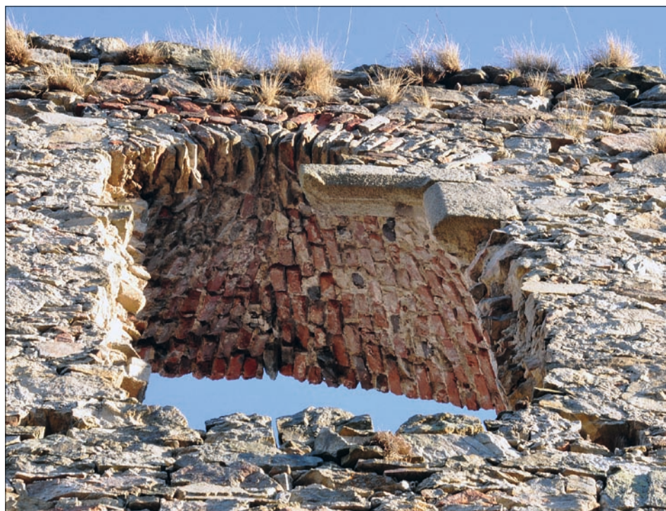
Obr. 50: Dívčí Kámen, jedno se západních oken sálu v západní obytné části paláce, pohled z exteriéru (srov. obr. 29, první okno zprava). V horní části zbytek stojky a překladu ostění, zjevně původně děleného křížem. V ostění je vidět drážka pro pevné zasklení. Záklenek niky okna je cihelný, stav 2017.
