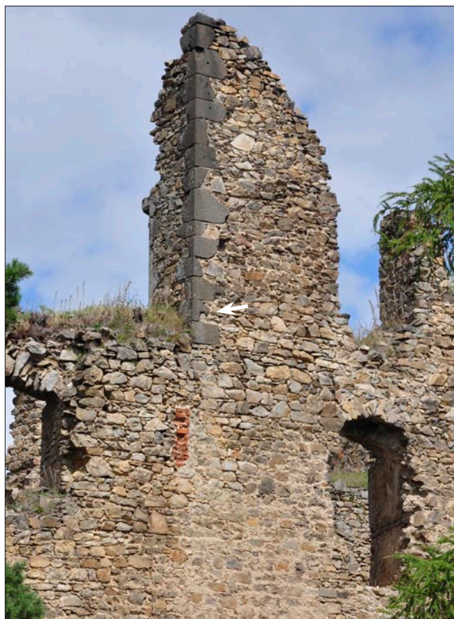
Obr. 106: Helfenburk, detail horních partií jižního průčelí paláce (srov. obr. 63a). Původní jihozápadní nároží východního sálu s armaturou a zbytkem sedlového portálku. V dolní části armatury kvádr profilovaný výžlabkem (označeno šipkou), původně určený na jinou část stavby (římso). Dole pod nárožím drobný obdélník z cihel, jehož účel je neznámý (vyskytuje se pod všemi čtyřmi nárožími sálových pater na rozhraní spojovacích zdí a obytných částí paláce), stav 2017.
