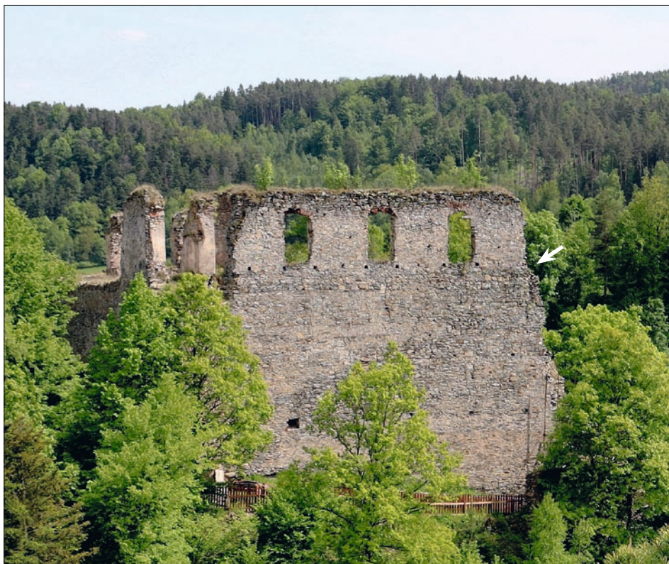
Obr. 29: Divčův Kámen, západní průčelí paláce se třemi okny sálového prostoru 3. patra. Těsně pod okny probíhá vodorovná řada otvorů po nosnících zaniklého dřevěného ochozu. Zcela upravo se v této úrovni rýsuje poněkud šikmé nasazení lince zdiva horního patra (označeno šipkou, srov. obr. 2, 20, 21) (snímek J. Hansová, 2021).
