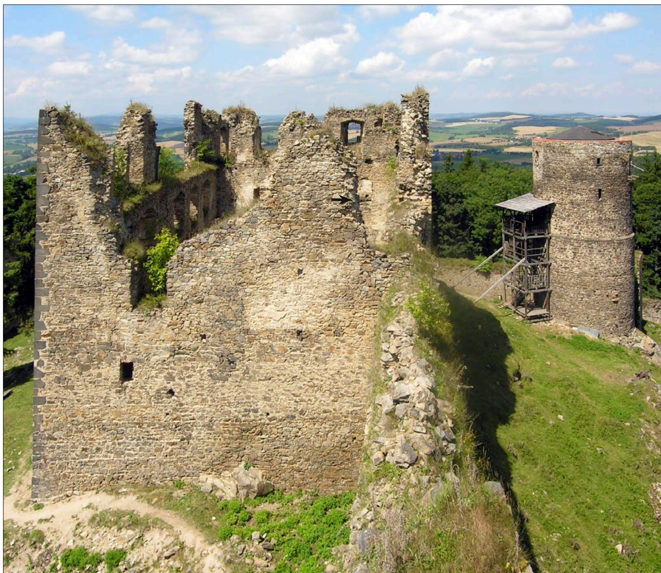
Obr. 96: Helfenburk, východní průčelí paláce v pohledu z menší válcové věže. Vpravo v pozadí větší válcová věž. Průčelí paláce je pod oknem 1. patra a vpravo od něj částečně přezděné. Upravené je také drobné okénko přízemí. Na vyvýšeném bloku zdiva vpravo od okna lze rozeznat část špalety jednoho z oken sálu a předstupující lomové kameny, které jsou zřejmě pozůstatkem mírně přesazené chodbičky v tloušťce zdiva k prevetu na severní fasádě (označeno šipkou). Vpravo na „řezu“ severní obvodovou zdí paláce se dochoval fragment špalety zaniklého okna v 2. patře. Vlevo uvnitř paláce najdeme zejména korunu jižní spojovací zdi se stojkou sedlového portálu do východního sálu, stav 2010.
