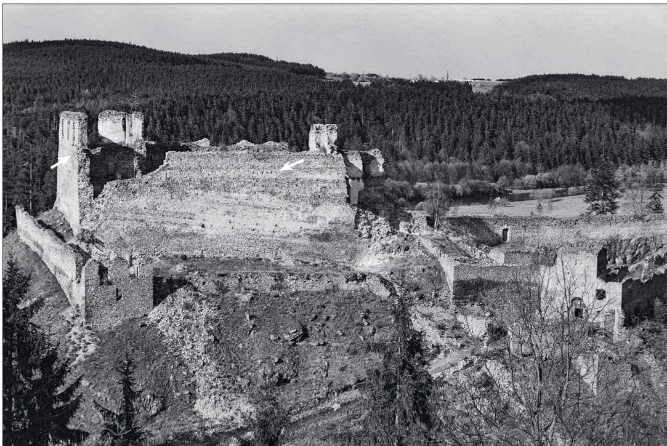
Obr. 2: Dívčí Kámen, celkový pohled na jádro hradu od jihu. Vlevo rozsáhlý palác chráněný parkánovou zdí, dole přístupový koridor zakončený věžovou branou (vpravo). Palác je charakteristický průčelím bez oken, na kterém lze dobře rozeznat v dolní části šikmo probíhající vrstvy zdiva a v části horní vrstvy vodorovné, s otvory po ochozu a sedlové věžici (označ. šipkou). Nad touto jižní spojovací zdí je v pozadí vidět koruna severní zdi, s pozůstatky předprvní zídky, event. cimbuří. Vlevo vyvýšená západní obytná část paláce. Šipkou vlevo označeno lokální šikmé založení horního, sálového patra. Vpravo (uprostřed snímku) vyčnívá horní patro východní obytné části (foto V. Hyhlík, 1963, archiv NPÚ GnŘ, č. 96139).
