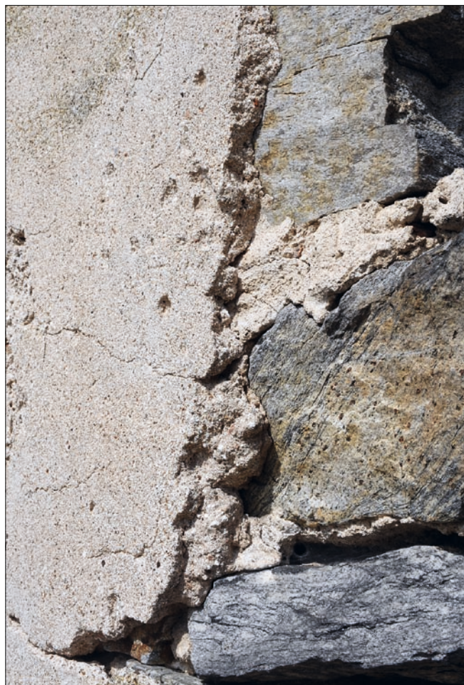
Obr. 46: Dívčí Kámen, detail jednovrstvé omítky ve 2. patře západní obytné části paláce, stav 2024.
