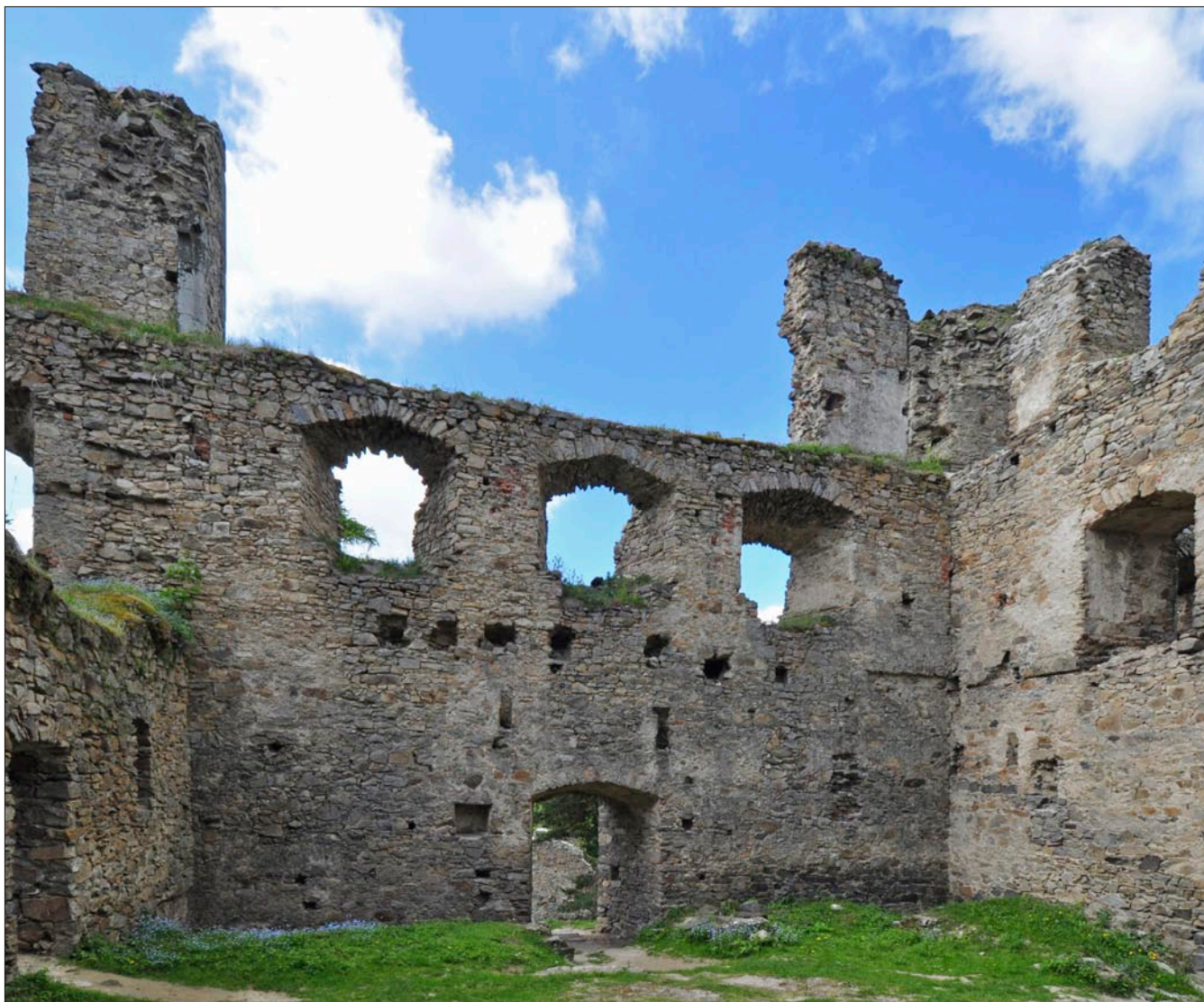
Obr. 89: Helfenburk, pohled z nádvoří paláce na jižní spojovací zeď. Uprostřed dole vchod s otvorem po závoře (srov. obr. 88), ale rekonstruovaný bez ostění. Vlevo od vchodu odkládací nika, pod ní začíná sestupová šje ke sklepu pod východní částí (vlevo). Nad vchodem dvě šikmé kapsy vzpěr nejasného účelu, výše vodorovná řada dodatečně vylámaných kapes. Nad nimi tři okna s postranními sedátky a pochvami pro závory, ostění zanikla (srov. obr. 89). Na koruně zdi probíhal ochoz, ústící oběma konci do portálků (dochovala se stojka levého a špaleta obou, s kapsami pro závory). Před stopami pravého portálku fragment druhotné nástavby spojovací zdi. Vlevo (na okraji obr.) se dobře dochovaly tzv. šmorce horní, zaniklé části nádvoří zdi. Po obou stranách jihozápadního koutu prostoru (vpravo) ve vyvýšené úrovni patrně stopy návaznosti druhotné arkády, stav 2017.
