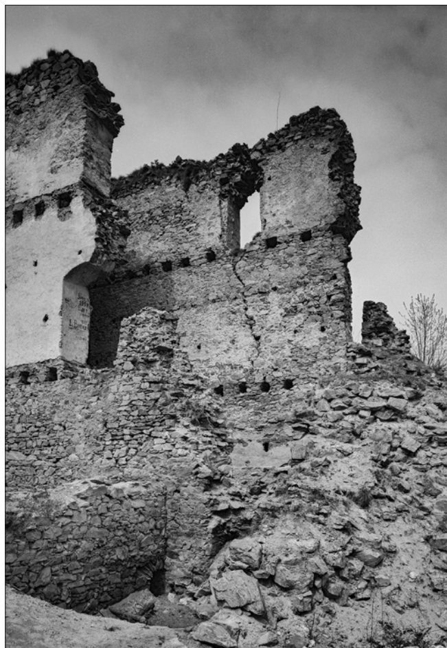
Obr. 56: Dívčí Kámen, pohled od jihovýchodního nároží ke vstupní partii paláce (srov. obr. 55). V popředí nárožní suterénní prostora jižního traktu, dnes zasypaná, s úzkým klenutým otvorem neznámého účelu ve zdi oddělující menší místnost pod vrátnicí (?) od větší místnosti (vlevo dole, srov. obr. 14). Výše dvě zdi vymezující v přízemí průjezd. Svislé zakončení severní z nich vpravo prozrazuje primární vznik obvodové zdi paláce přibližně do výšky podlahy 2. patra (25) (foto Č. Šíla, 1962, archiv NPÚ GnŘ, č. 91868).
