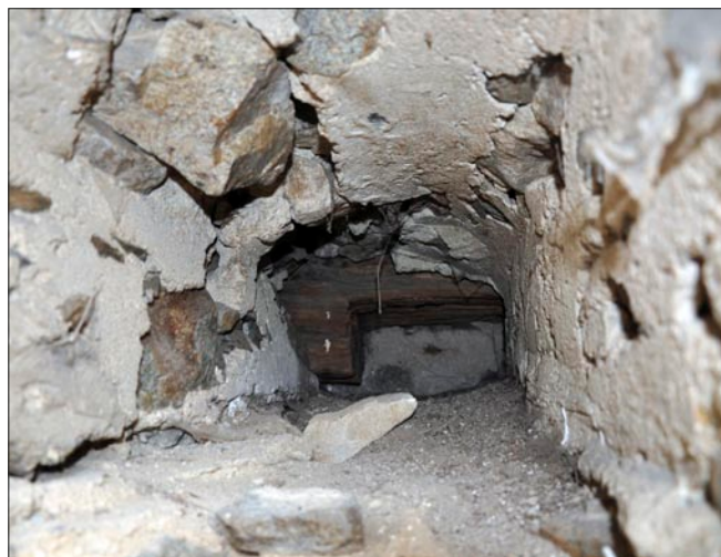
Obr. 68: Helfenburk, pohled do hluboké kapsy po zaniklém trámovém nosníku v jihozápadním koutě nádvoří (obr. 66 vlevo), který byl součástí pavlače v úrovni podlahy 1. patra západní obytné části paláce. U konce otvoru vidíme dřevěný prvek v podobě háku, který kotvil uvedený nosník, stav 2015.
