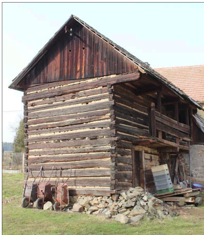
Obr. 15: Borek u Kozojed (okres Plzeň-sever), usedlost čp. 5, roubená patrová sýpka s pavláčkou, pohled od jihovýchodu, stav 2021.
