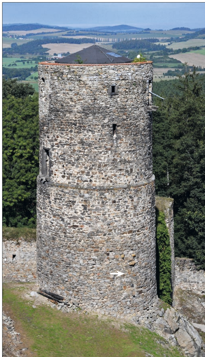
Obr. 10: Helfenburk, velká válcová věž v pohledu z paláce. Vysoká přízemní část je zakončená římsou, nad níž zdivo ustupuje. Vpravo dole „šmorce“ připravené k navázání zdi, k němuž nedošlo (označeno šipkou). Sedlový portálek do 1. patra je vybaven dvěma konzolami, ve kterých však nebyla připravena ložiska pro točnice padacího můstku. Nahoře okénka jednotlivých pater a vstup do zaniklého arkýřového prevetu, s dřevěnými konzolami. Svrchní část zdiva a partie s okénkem vlevo jsou dílem novodobé rekonstrukce, stav 2022.
