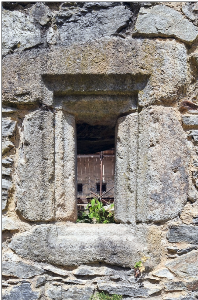
Obr. 34: Dívčí Kámen, ostění přízemního okénka jižního traktu západní obytné části paláce (23), stav 2024.
