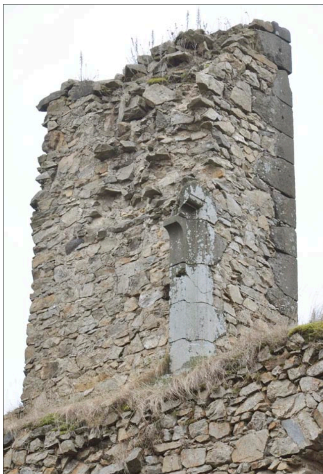
Obr. 107: Helfenburk, pohled z nádvoří na dochovanou část sedlového portálku z jižní spojovací zdi do 2. patra východní obytné části (srov. obr. 97 a 98). Za portálkem je vidět špaletu se stopami záklenku a ústím pochvy závory, stav 2015.
