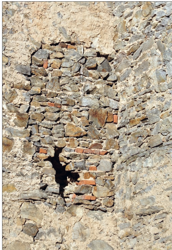
Obr. 35: Dívčí Kámen, detail zazděného vchodu (7) z původního ochozu severní spojovací zdi (uvnitř 2. patra v dolní části křbu). Vpravo je vidět nechtěné odstupňování této zdi v důsledku dodatečného zvyšování, stav 2017 (srov. obr. 31–33).
