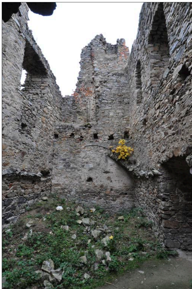
Obr. 108: Helfenburk, pohled od západu do severního traktu východní obytné části (srov. obr. 99). V přízemí zbytky valené klenby, nad ní kapsy trámů dodatečného stropu. Na ními prohlubeň krbu, vedle ní v 2. patře drobný výklenek. Vpravo v 1. patře průchod do jižní místnosti a výklenek skříňky, vlevo okno 1. patra k severu, jehož ostění zaniklo, stav 2015.
