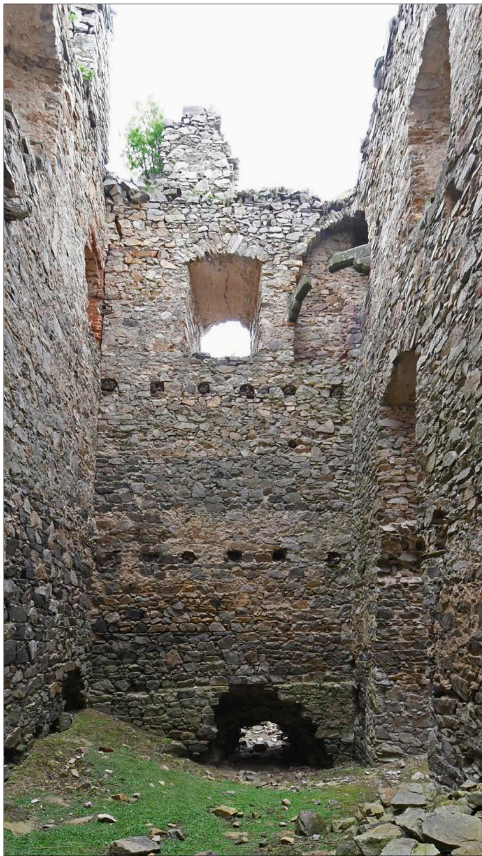
Obr. 78: Helfenburk, severní trakt západní obytné části paláce, průhled směrem k východu (srov. obr. 64b vlevo). V čele nádvoří zeď se zbytky stropních trámů nad horním sklepem a přízemím. Dole pod odsazením líce zdiva olámaný vstup z nádvoří do takřka zasypaného dolního sklepa (snímek je pořízen z povrchu tohoto zásypu). Nahoře 1. patro s oknem na ose a pozůstatky koutového krbu vpravo. Z druhého patra vidíme blok zdiva mezi vchodem na tamější prevet (v koutě) a širokým otvorem domnělé arkýřové kaple. Vlevo severní zeď se špaletou okna a vstupem do prevetu (srov. obr. 80). Dole těsně nad zásypem vlevo kapsy po stropních trámech dolního sklepa. Vpravo mezitraktová zeď s vchody do horního sklepa (prohloubení na úrovni zásypu dolního sklepa je novodobé) a přízemí. Nahoře průchod do jižní místnosti, stav 2008.
