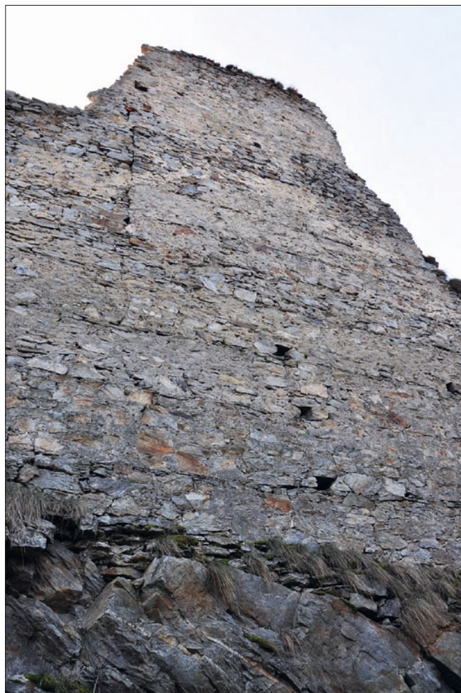
Obr. 27: Dívčí Kámen, severní průčelí paláce, detail rozhraní mezi západní obytnou částí (uprostřed) a spojovací zdi (vlevo). Uvedené části stavby vzájemně odděluje svislá spára (vlevo nahoře), srov. obr. 22/20, stav 2011.
