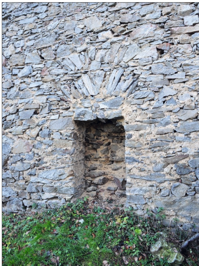
Obr. 28: Dívčí Kámen, celkový pohled z nádvoří na severní spojovací zeď (srov. obr. 23). Dole uprostřed dodatečný průraz do severního parkánu. Nerovnosti líce v sousedství průrazu podporují závěr o dodatečném vzniku otvoru. Po stranách dochované části rostlé skály, využité při stavbě zdi. Vlevo (nad dřevěným přístřeškem) je patrný mírný zlom v průběhu líce. Vlevo v nádvoří zdi západní obytné části zazděný otvor (7), patrně původní vchod z ochozu spojovací zdi (obr. 35). Otvor byl nejspíše zazděn při prvním zvýšení této zdi. V pozadí nad koutem styku spojovací zdi a průčelí obytné části relikv kaple s koutem jejího interiéru, kde lze rozeznat zbytky cihelné klenby (12), stav 2024.
