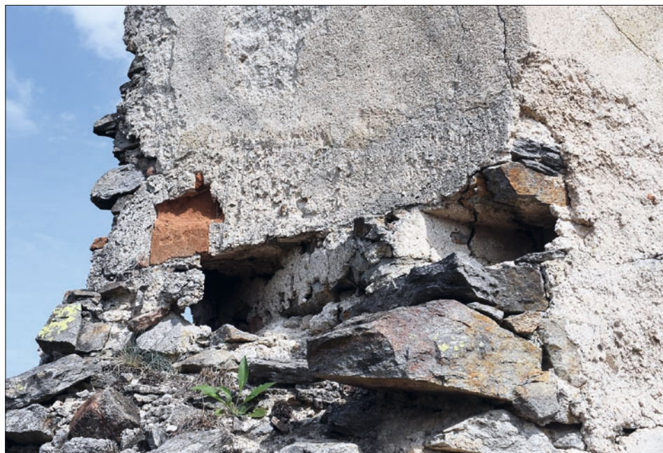
Obr. 49: Dívčí Kámen, detail jednoho se západních oken sálu v západní obytné části paláce, pohled z interiéru. Nahoře dolní část šikmé špalety, pod ní otvory po vzájemně kolmých vodorovných trámech, které se protínaly. Levý z nich byl nosíkem vnějšího ochozu, pravý kotvil jeho vnitřní konec (srov. obr. 32 vlevo nahoře a 38/10), stav 2024.
