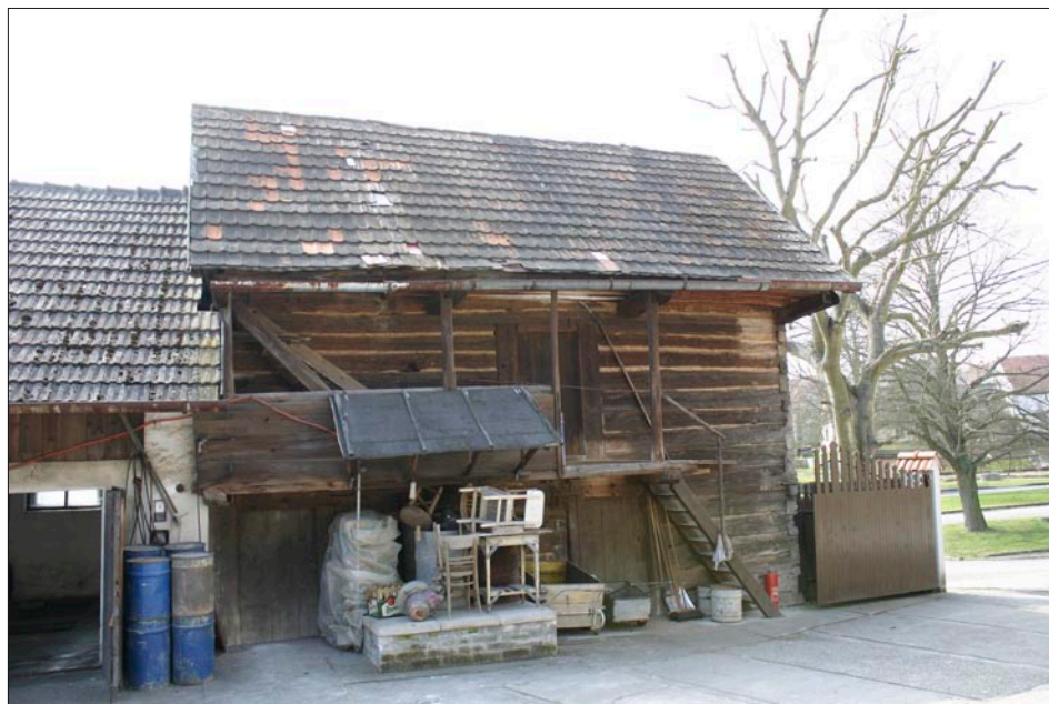
Obr. 12: Jarov, usedlost č. 21, dvorní (severovýchodní) strana roubené patrové sýpky s pavláčkou, stav 2015.
