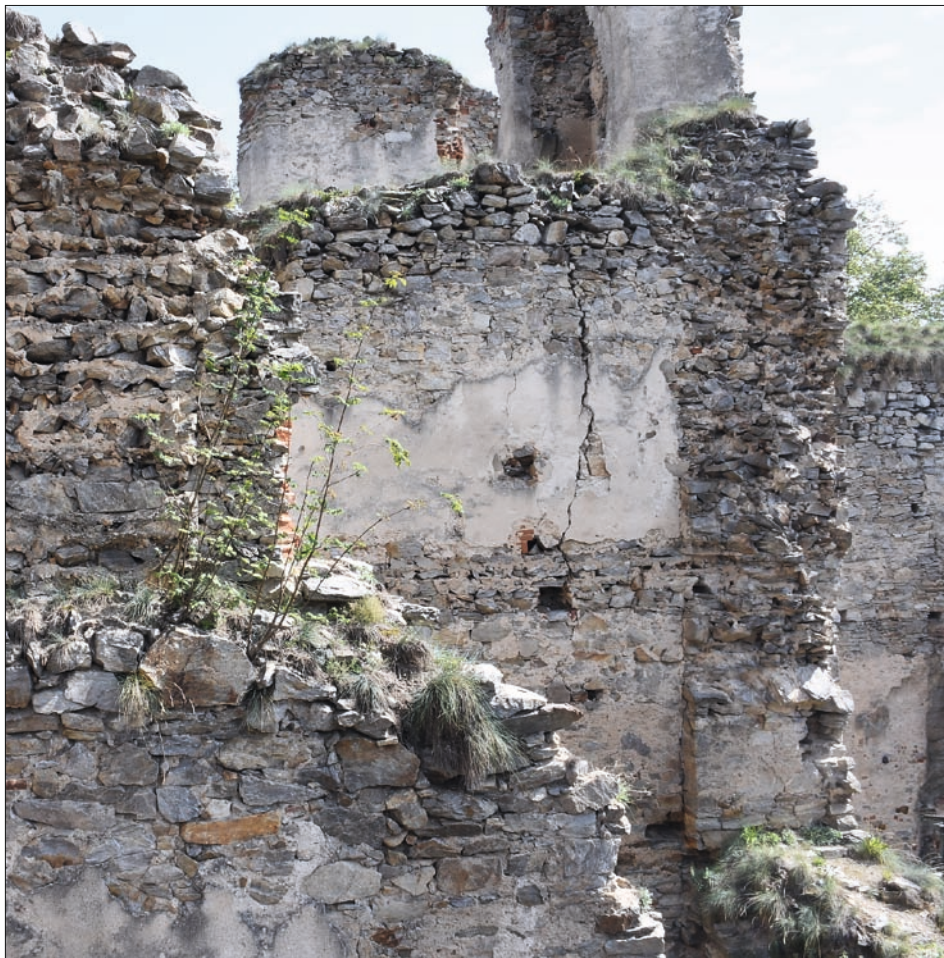
Obr. 47: Dívčí Kámen, západní obytná část paláce, pohled z 2., původně vydřeveného patra jižního traktu k severu. V popředí vlevo (za náletovou vegetací) část stěny jižní místnosti s otiskem výdřevy a stojkou jinak zaniklého obslužného otvoru kamen (9). Rozeznat lze i stopu napojení kamen na otvor a na dřevěné zateplení (vlevo uprostřed výšky snímku). V pozadí severní stěna středního traktu – dole 1. patro se špaletou nádvorního okénka, nahoře 2. patro se zbytky plošné omítky (srov. obr. 41). Nahoře v pozadí zdívo s krbem a špaletou severního okna sálu (vedle kaple), stav 2024.
