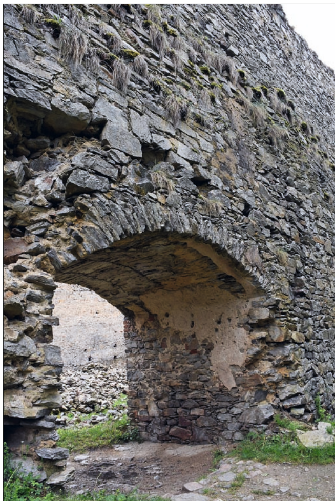
Obr. 26: Dívčí Kámen, průchod v severní spojovací zdi (4), šikmý pohled z parkánu od severovýchodu. Nad záklenkem zdi zesilující zeď, původní líc zcela nahoře (srov. obr. 22/3 a 25), stav 2024.
