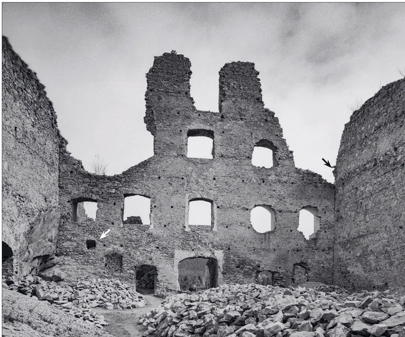
Obr. 52: Divčí Kámen, nádvorní průčelí východní obytné části. Okna všech čtyř podlaží přišla o ostění, místy se však dochovaly omítkové pasparty na jejich obvodu. Hlazená pasparta lemuje také vjezd do průjezdu. Průčelní zeď je k obvodové zdi přiložena oběma svými konci na spáru. Nad horním koncem pravé spáry vystupuje několik vazacích kamenů (označ. šipkou), jsou však součástí teprve dodatečného zvýšení obvodové zdi (srov. obr. 18 a 21). Vlevo dole přibližně čtvercové okénko (označ. šipkou), snad související s topením v přízemí severní místnosti (2) (foto Č. Šíla, 1962, archiv NPÚ GnŘ, č. 91863).
