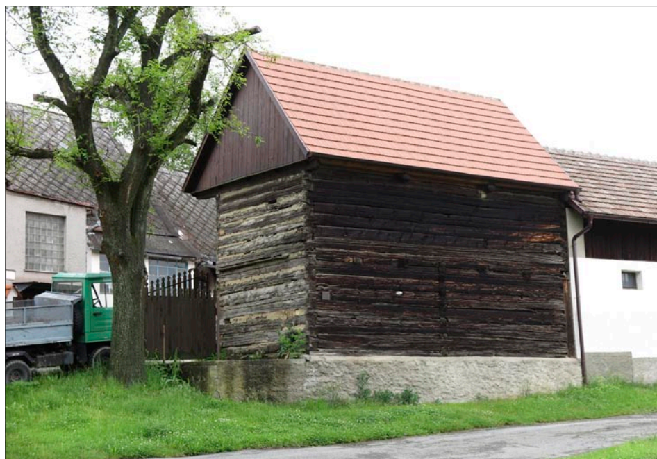
Obr. 11: Jarov, usedlost čp. 21, pohled z návsi (od západu) na roubenou patrovou sýpku, stav 2024.
