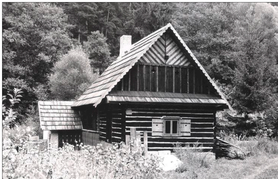
Obr. 6: Rabštejn nad Střelou (okres Plzeň-sever), někdejší kolna u sýpky ze dvora čp. 2 v Jarově, transferovaná do Rabštejna nad Střelou a upravená k obytnému účelu (foto J. Gryc, 1988; archiv NPÚ ÚOP v Plzni).
