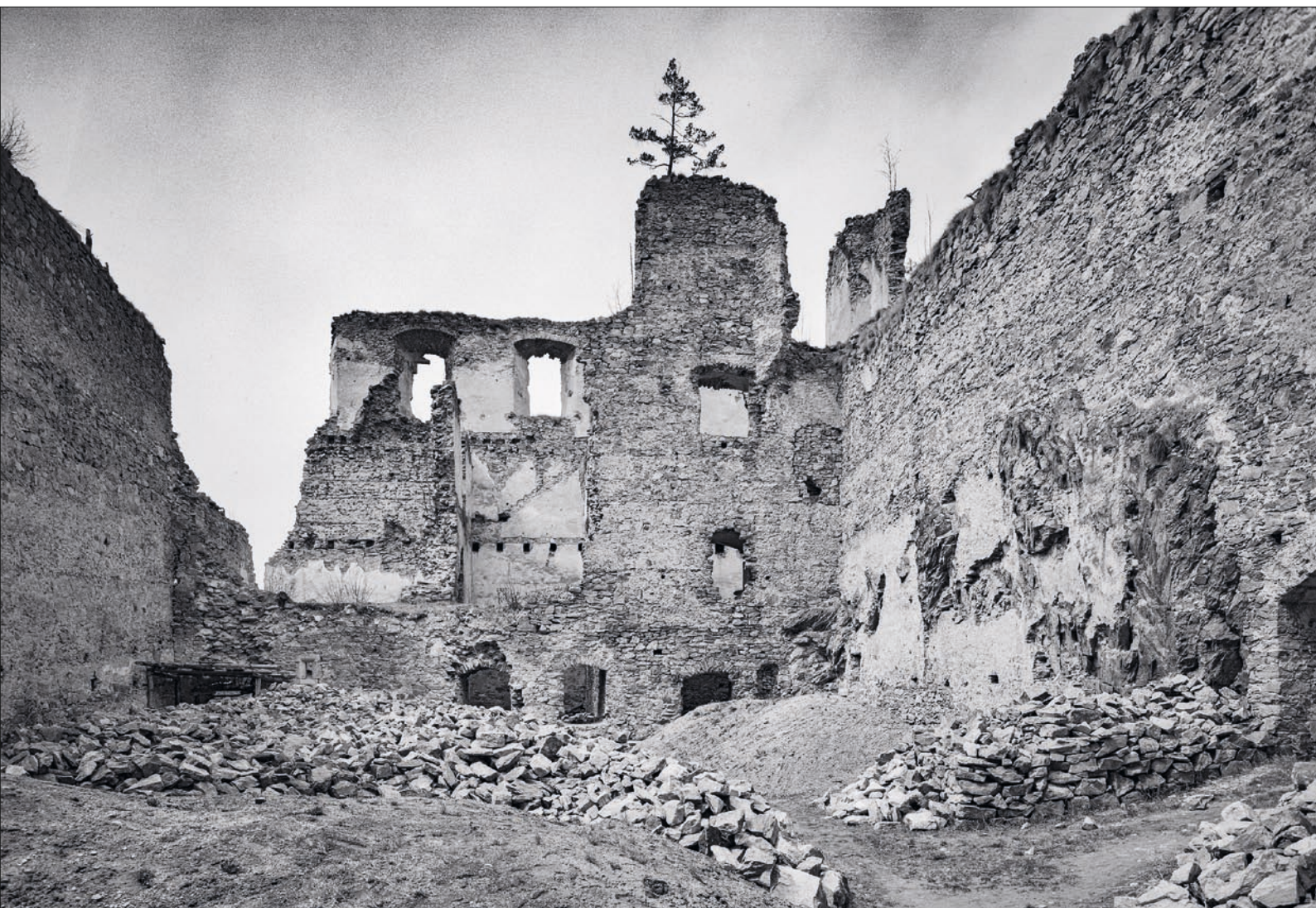
Obr. 33: Dívčí Kámen, takřka stejný pohled (srov. obr. 32, též 28) na archivním snímku poskytuje představu o postupné destrukci od 60. let 20. století do současnosti (foto Č. Šíla, 1962, archiv NPÚ GnR, č. 91857).
