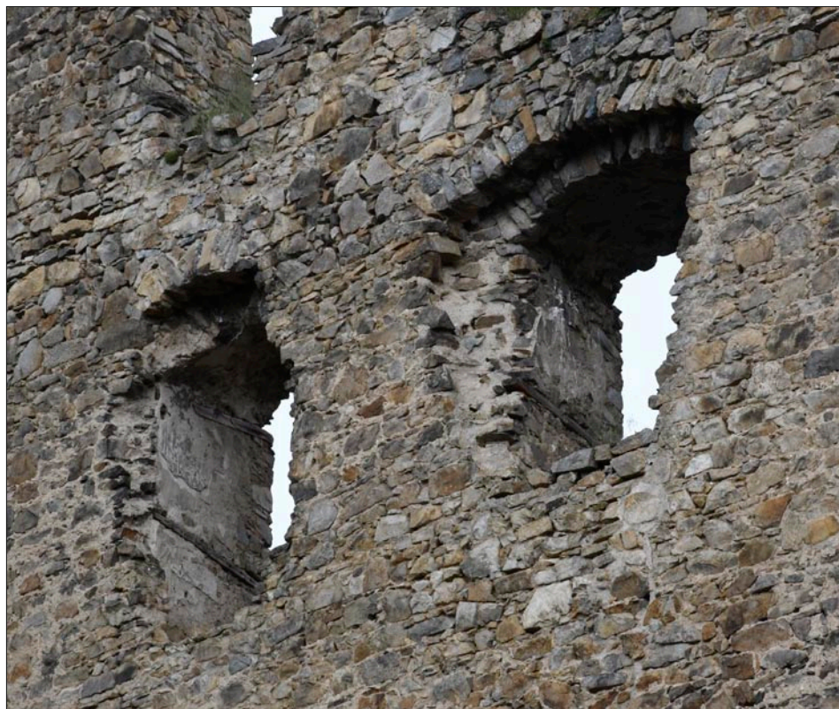
Obr. 105: Helfenburk, dvojice oken 1. patra v jižním průčelí východní obytné části paláce (srov. obr. 102). Dochované negativy zaniklých ostění napovídají, že samotné okenní otvory byly i přes široce rozevřené špalety na straně interiéru poměrně malé (stejně jako v západní obytné části). Ve špaletách jsou vidět lišty po deštění, částečně zakryté pozdější omítkou (vlevo). Vlevo nahoře spodní část okna ve 2. patře, s pozůstatky postranních sedátek, stav 2024.
