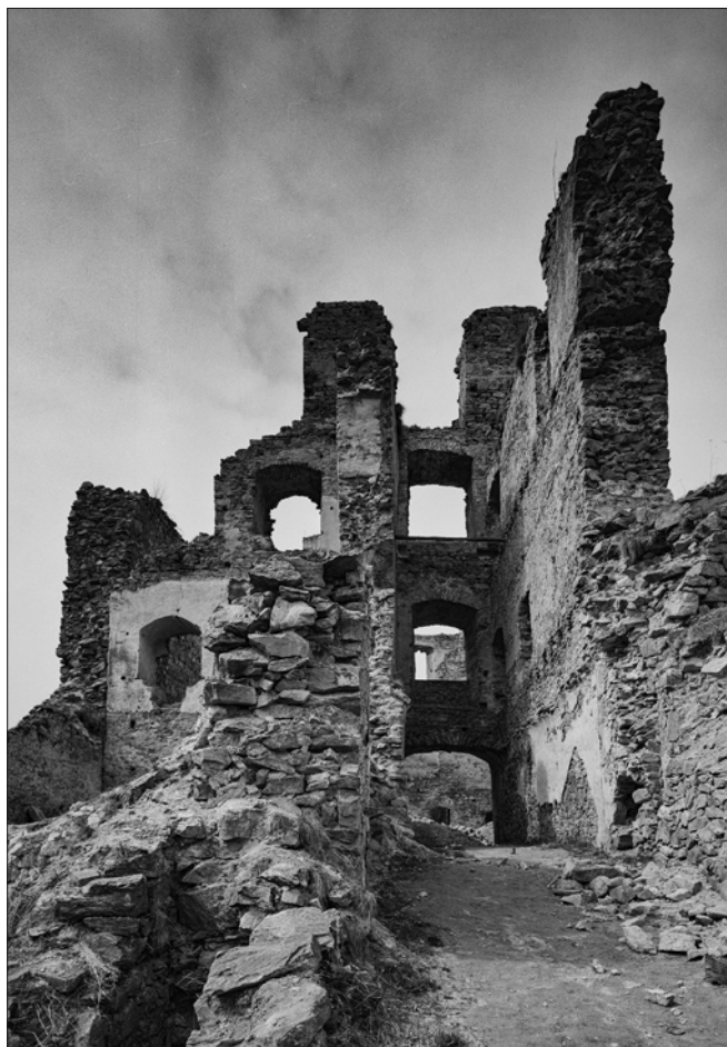
Obr. 55: Dívčí Kámen, pohled od východu k průjezdu brány. V popředí předpokládané předbrání s „výřezem“ nejasného účelu vlevo. Vpravo nahoře otisk zaniklé obvodové zdi (v rozsahu 1. patra severní mezitraktové zdi), srov. obr. 14, 17, 54 a 56 (foto Č. Šíla, 1962, archiv NPÚ GnŘ, č. 91867).
