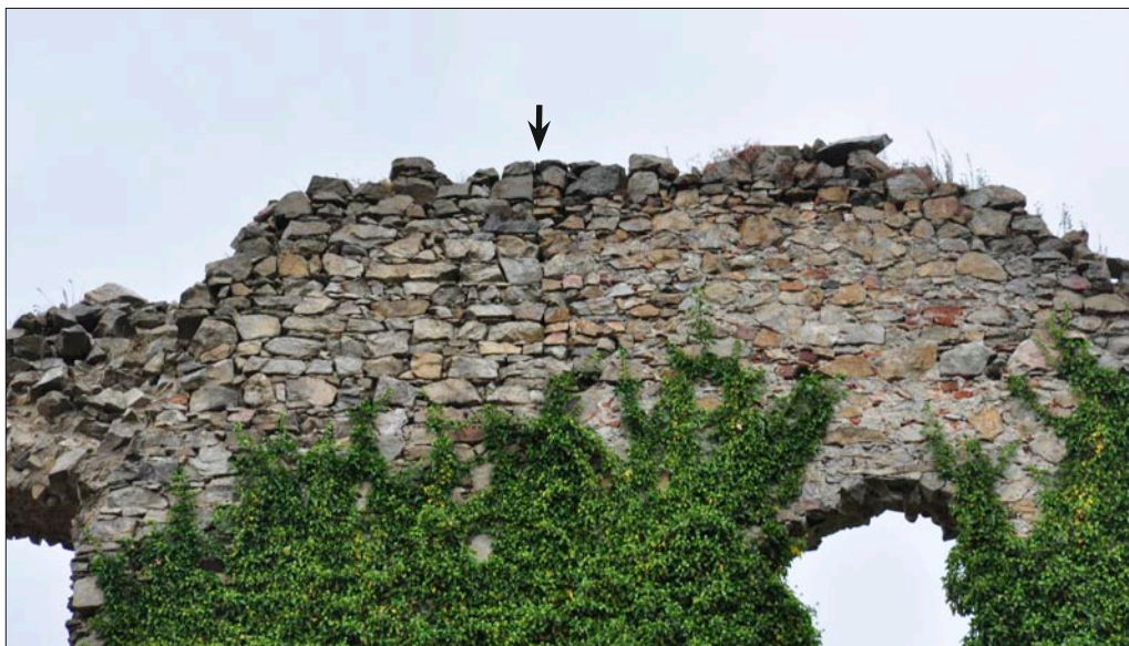
Obr. 95: Helfenburk, detail horních partií severního průčelí paláce, rozhraní (šipka) mezi nárožím sálového patra východní obytné části (vlevo) a pozdější nástavbou spojovací zdi (vpravo). Líce různého původu se vzájemně liší strukturou (v pravé je větší obsah úlomků páleného materiálu), starší nároží zde však nemá (na rozdíl od jižního fragmentu nástavby na obr. 94) kvádrou armaturu, stav 2017.
