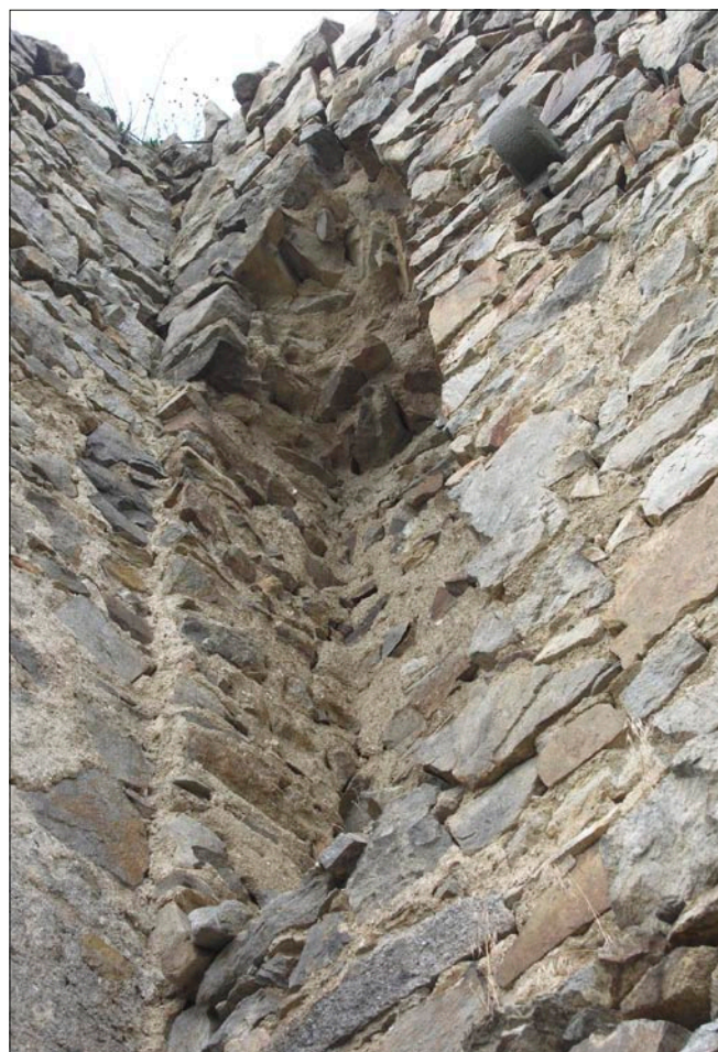
Obr. 76: Helfenburk, původně dřevem vyložená skříňka v jihozápadním rohu západního sálu paláce (nadpraží je zříceně). Vpravo od ní drobná kamenná konzola nejasného účelu (srov. obr. 64c, 69 vlevo), stav 2008.
