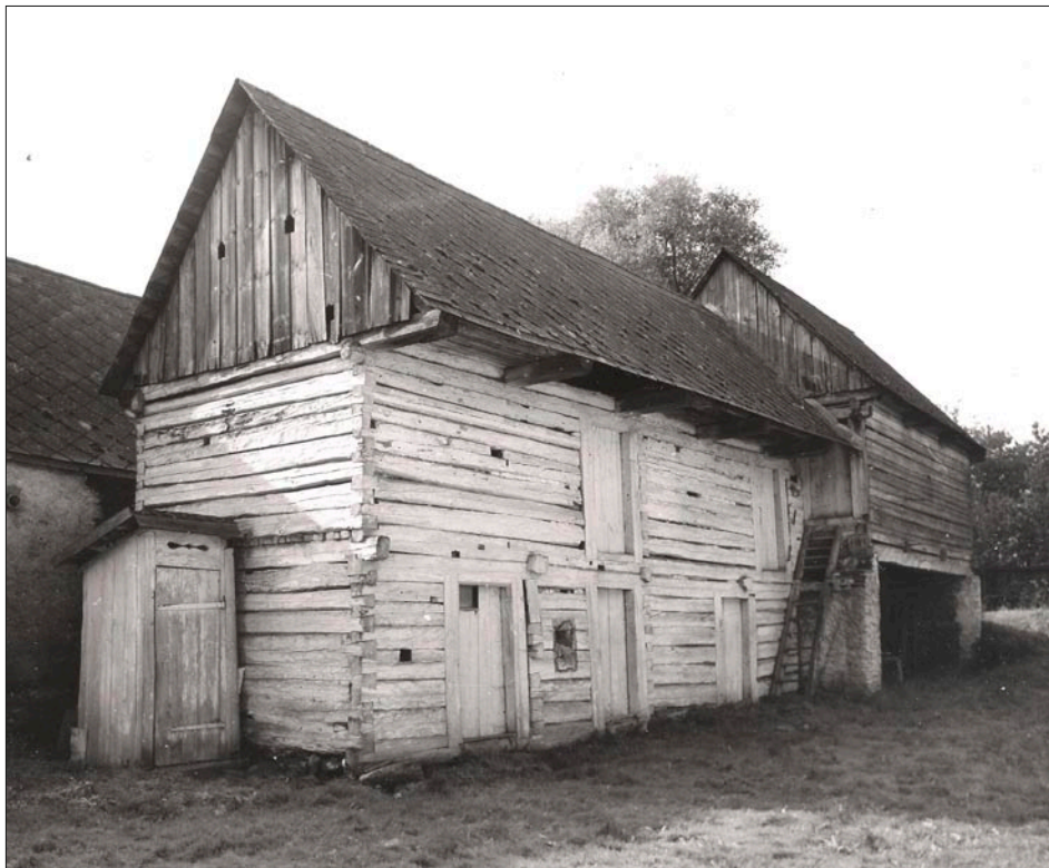
Obr. 8: Jarov, usedlost čp. 12, roubená patrová sýpka, původně vybavená pavláčkou, pohled od severu (foto J. Vajdiš, 1970; archiv NPÚ ÚOP v Plzni).
