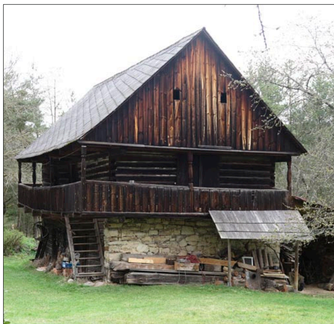
Obr. 16: Radějov (okres Plzeň-sever), usedlost čp. 1, roubená patrová sýpka s pavláčkou, pohled od jihovýchodu, stav 2024.
