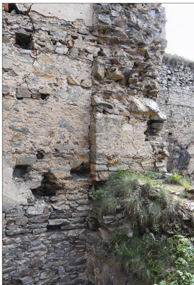
Obr. 41: Dívčí Kámen, detail severní stěny 1. patra středního traktu v západním dílu paláce. Vpravo špaleta okénka v nádvorní zdi (5). Zřetelná je původní úroveň parapetu i patky záklenku, pod níž nepřehlédneme otvor pochvy pro závory, stav 2024 (srov. obr. 40 vpravo).
