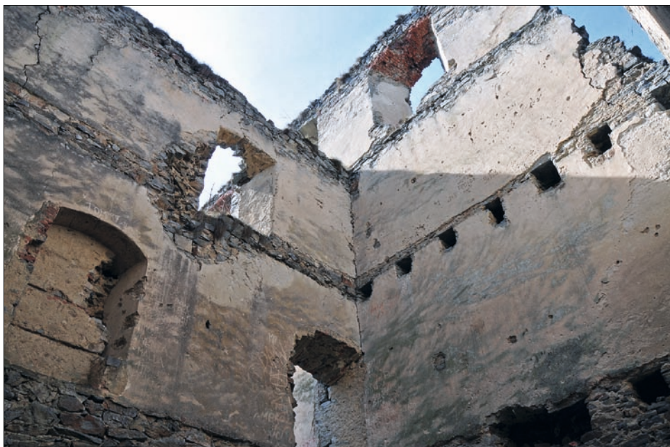
Obr. 43: Dívčí Kámen, detail interiéru severního traktu západní obytné části. Vlevo mezitraktová zeď s úložným výklenkem a průchodem v 1. patře, další průchod o patro výše. Vpravo nahoře okno v západní zdi sálu. Stěny pater jsou na rozdíl od přízemí omítnuté, stav 2011.
