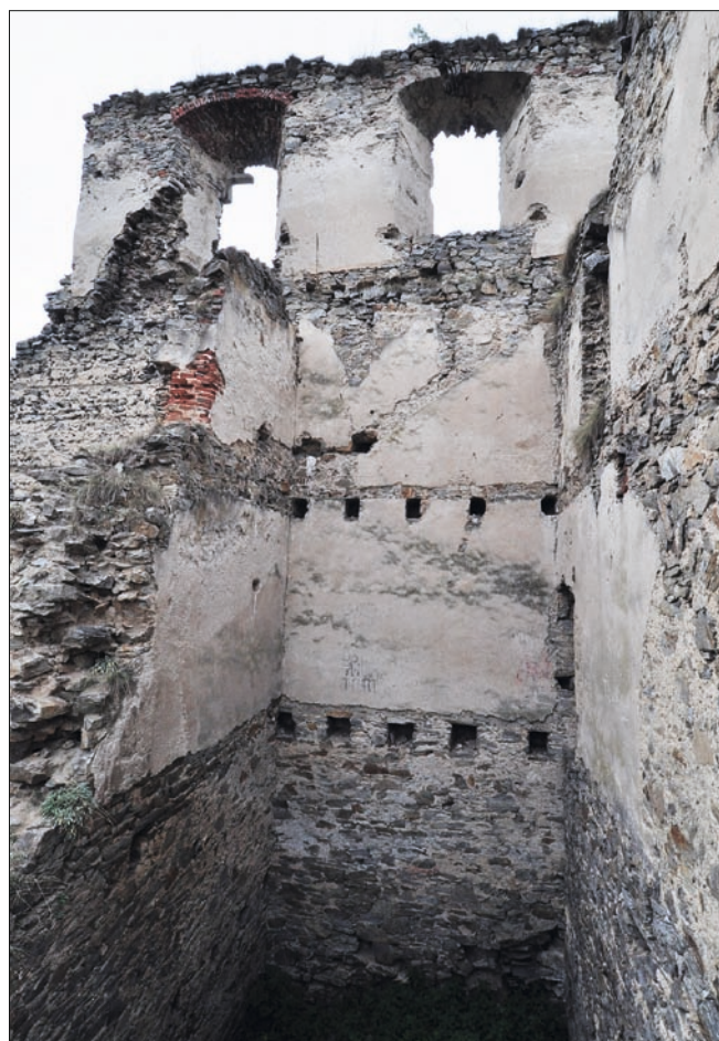
Obr. 39: Dívčí Kámen, střední trakt západní obytné části paláce, průhled interiérem k západu (srov. obr. 38 uprostřed). Dole neomítnuté přízemí, nad ním 1. patro s průchodem do severního traktu (vpravo), s otvorem po pochvě závory. Výše 2. patro s otiskem schodiště a jeho podesty, vpravo průchod do severního traktu, vlevo cihelná stojka obslužného otvoru kamen v jižním traktu. Nahoře okna sálu 3. patra se zbytkem ostění (srov. obr. 50) a několika otvory v místech zazdění nosníků ven předsazeného ochozu, stav 2013.
