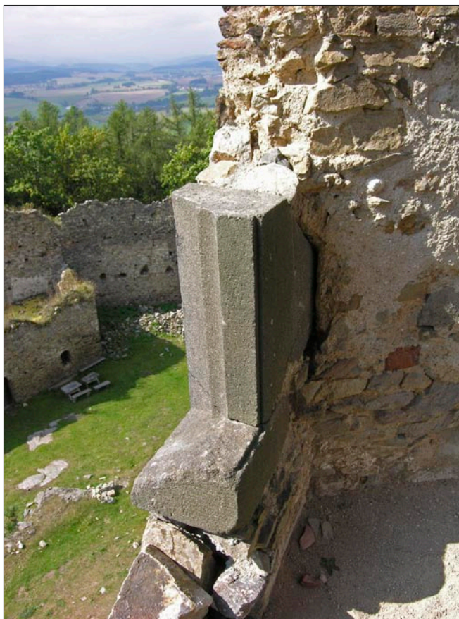
Obr. 73: Helfenburk, fragment ostění v 1. patře jižního průčelí západní obytné části (srov. obr. 72). Na vnitřní hraně je zřetelná pravoúhlá drážka pro okenici, stav 2008.
