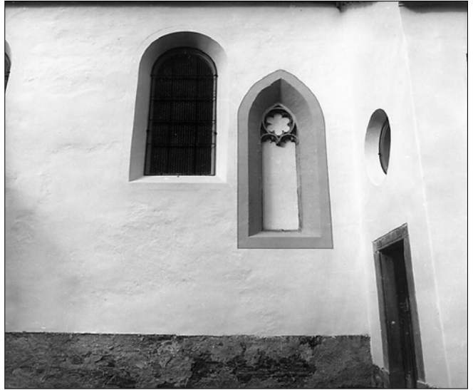
Obr. 4: Jižní strana lodi, pohled na odhalené gotické okenní ostění s křížbou, stav po opravě. (Foto K. Foud, 1995.)
