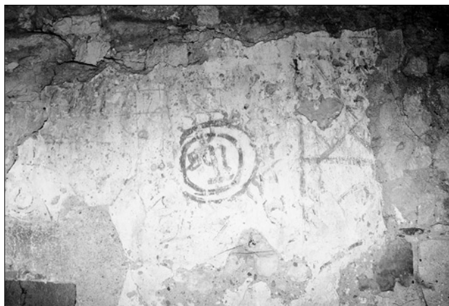
Obr. 20: Mušov, kostel sv. Leonarda, motiv sluneční monstrance s trigramem ihs na východní stěně presbytáře pod gotickým oknem (foto D. Černouškova, 1996).
