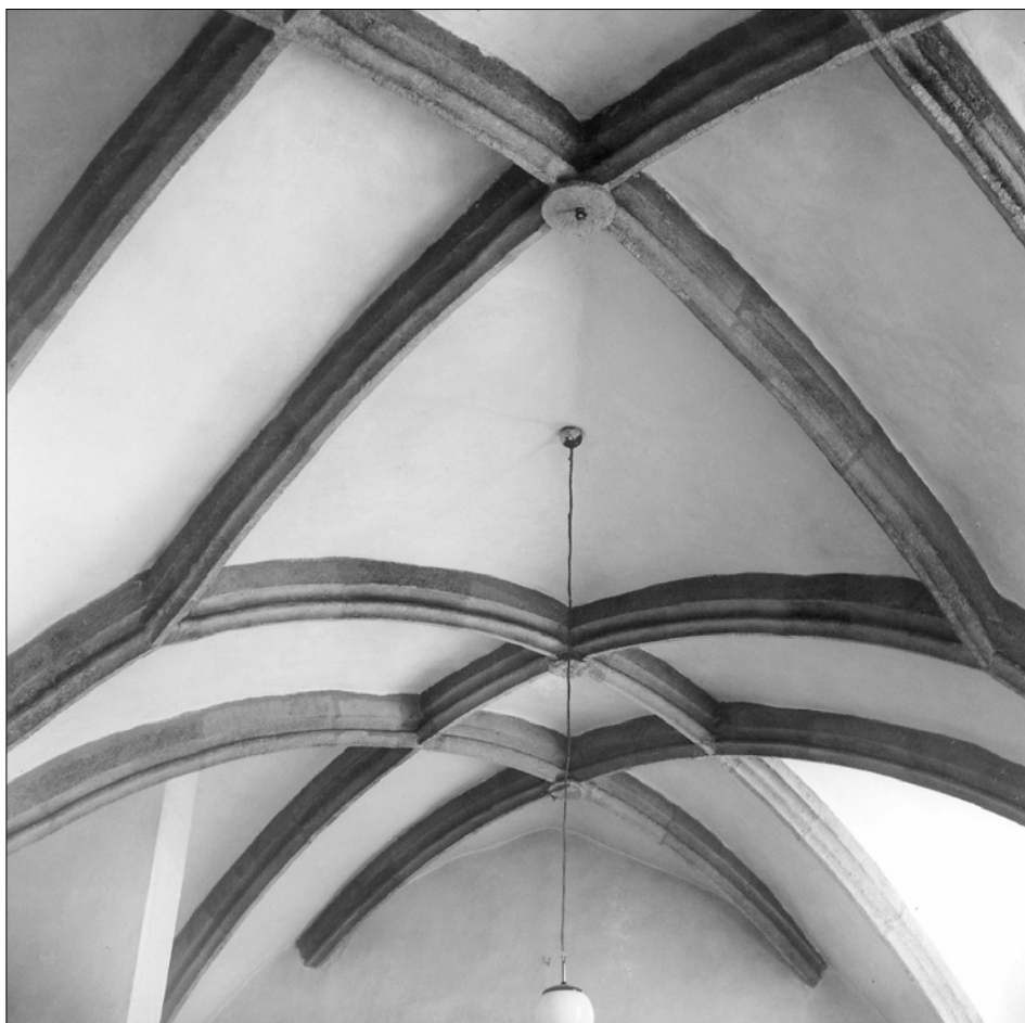
Obr. 7: Kroměříž, síťová klenba vikářské sakristie; podélný pohled po vrcholnici klenby od východu k západu. V levém dolním rohu část opěrného pilíře z brunonské stavby. Stav po restituci (foto autor, 1968).
