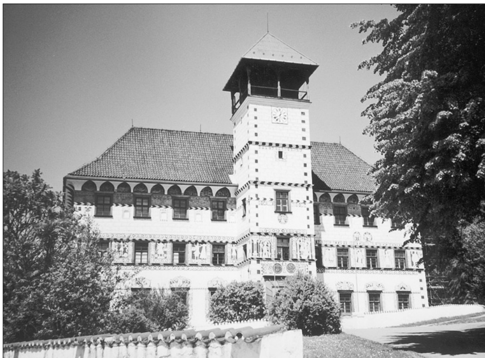
Obr. 1: Stará Ves nad Ondřejnicí (okres Frýdek - Místek), průčelí zámku po opravě v roce 2000 (všechny snímky L. Dědková, není-li uvedeno jinak).
