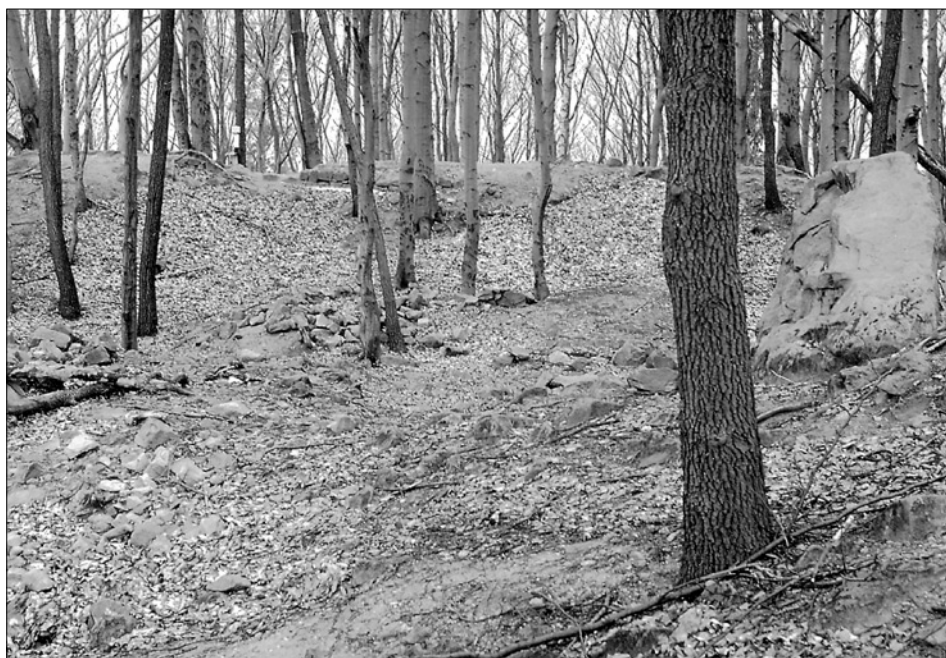
Obr. 20: Starý Světlov, současný stav partie z obr. 19, koruna zřícenin hradby je (zvláště v levé partii) výrazně snížena.
