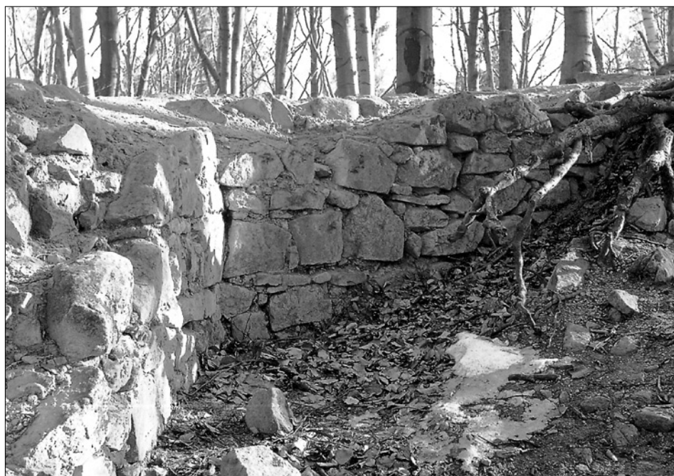
Obr. 9: Starý Světlov, vnitřní líce severozápadního koutu obvodové hradby jádra, pohled od jihu.
