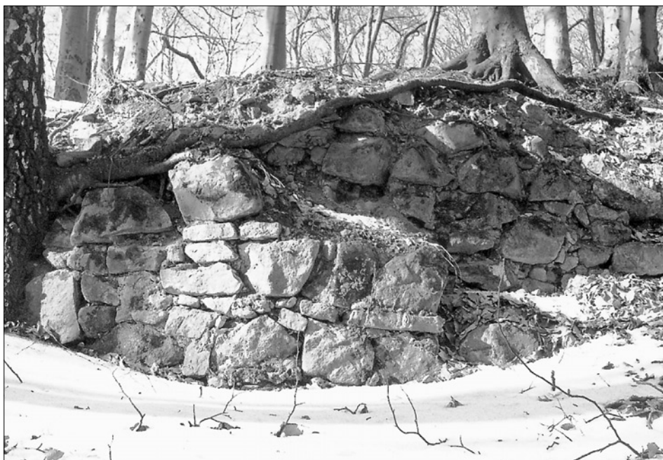
Obr. 7: Starý Světlav, partie parkánové hradby jako na obr. 6 – stav po destrukci západní části líce.
