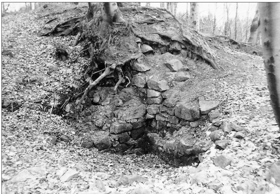
Obr. 11: Starý Světlov, pohled na severní kout místnosti hradního paláce (3. místnost od západu); ve výkopu je zachycena část líce interiérové přičky (vlevo), přiložené na spáru k vnitřní líci obvodové hradby jádra; na pravo od styku přičky s hradbou je patrný fragment interiérové přízdívky; pohled od jihu, stav v roce 1988.
