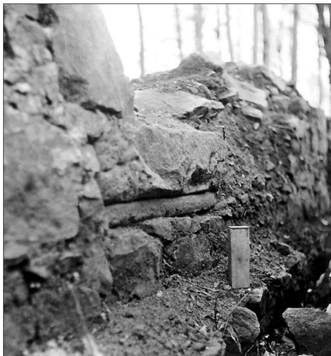
Obr. 10: Starý Světlov, druhotně použitý architektonický článek u jihozápadního nároží paláce; v dolní části snímku patrný rozšířený sokl zdiva; pohled od západu, stav v roce 1984.
