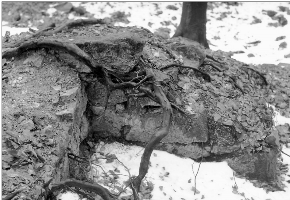
Obr. 13: Starý Světlav, pohled na nelegálním výkopem odkrytý blok zdiva; vlevo vnější líc nádvorní zdi paláce, vpravo zdivo a západní nároží bloku; na povrchu kamenů zbytky maltové úpravy, pohled od západu, stav v roce 1999.
