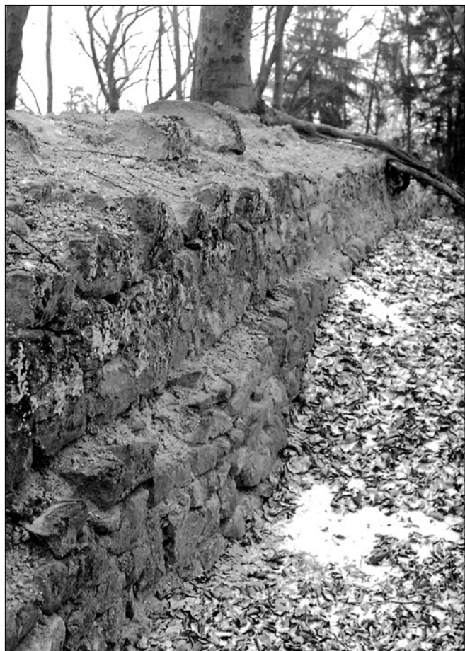
Obr. 5: Starý Světlav, část vnější líce západní partie parkánové hradby jádra; na snímku patrné zesílení spodní partie zdiva a zbytky vápenných líček na horní části; pohled od severozápadu.
