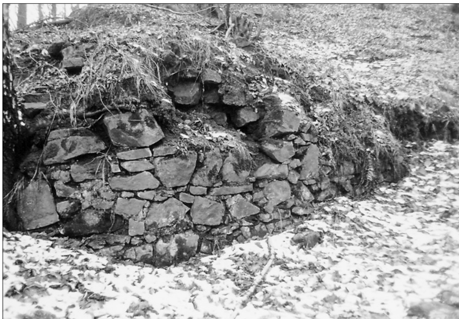
Obr. 6: Starý Světlav, zaoblené severovýchodní nároží parkánové hradby jádra, pohled od východu, stav v roce 1988.
