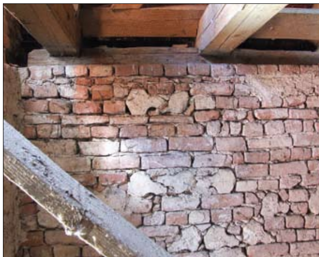
Obr. 10: Pouzdřany, kostel sv. Mikuláše, podkroví lodi – jižní zeď s druhotně použitými architektonickými články.
