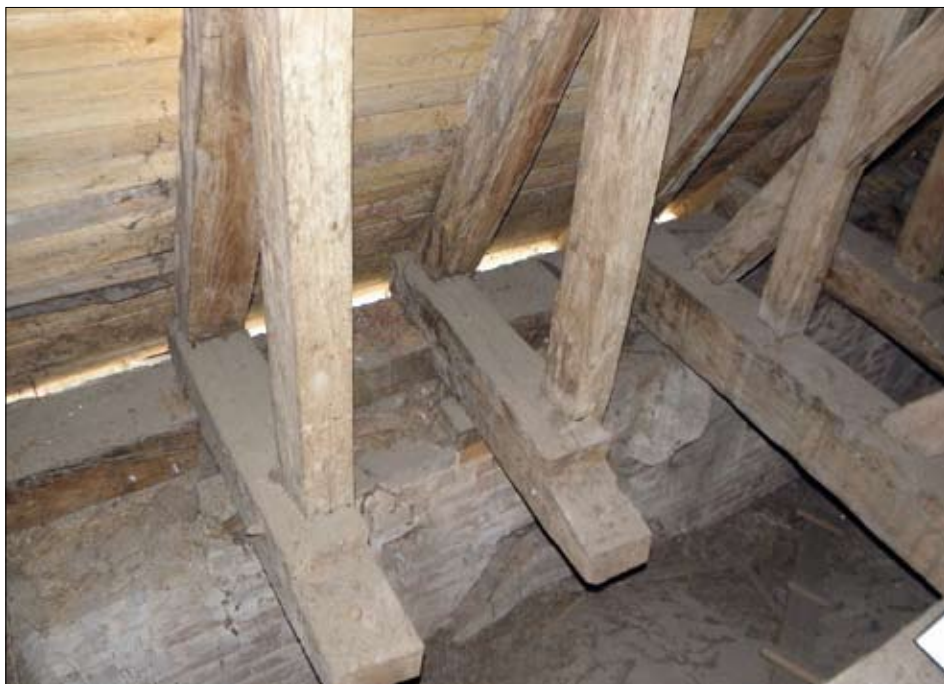
Obr. 6: Pouzdřany, kostel sv. Mikuláše, krov presbytáře – detail vyřezaných vazných trámů.
