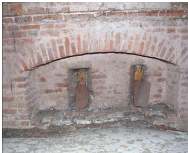
Obr. 11: Pouzdřany, kostel sv. Mikuláše, podkroví lodi – severní zeď se střílnami.
