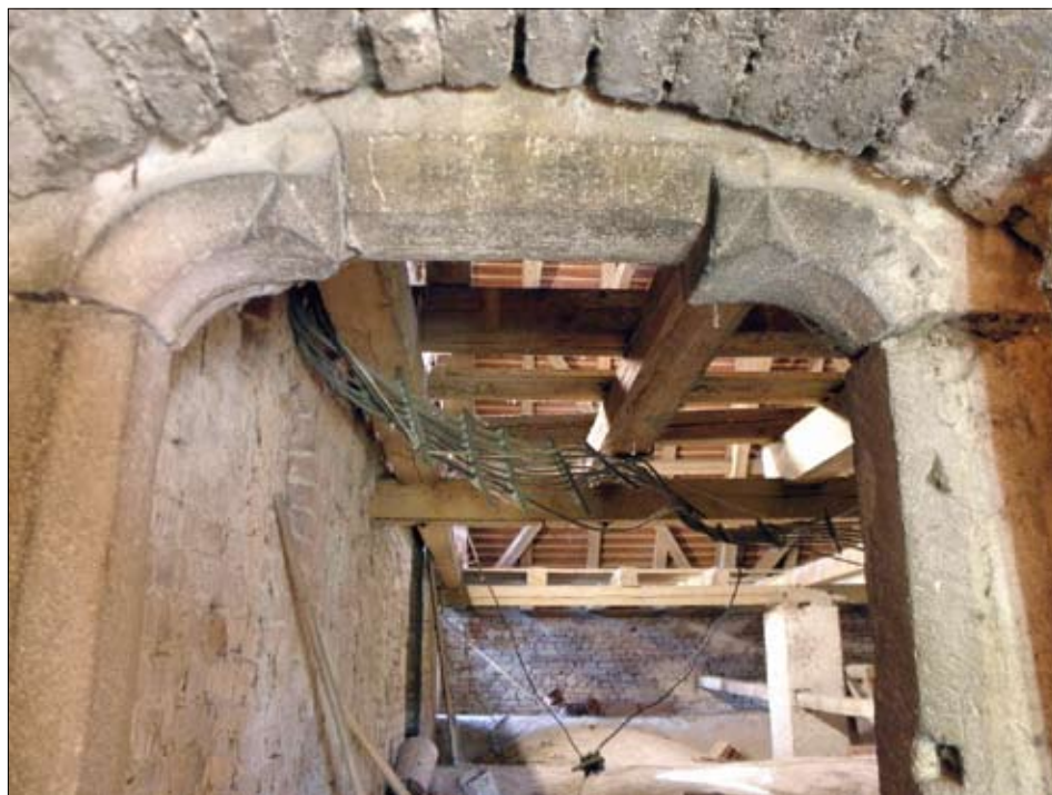
Obr. 9: Pouzdřany, kostel sv. Mikuláše, portálek vedoucí do podkroví lodi.
