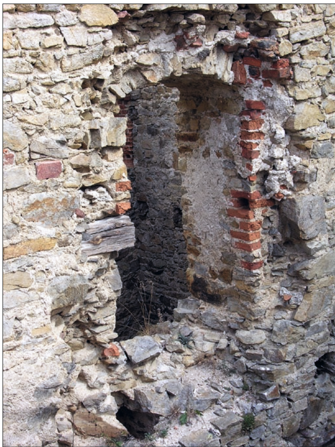
Obr. 12a, b: Helfenburk, porovnání průchodu v 1. patře mezitraktové zdi západní obytné části paláce, pohled z jižní místnosti, stav 2008 a 2015 (srov. obr. 69). Přes zánik ostění měl otvor velkou vypovídací schopnost, která se rasančně snížila způsobem jeho stavebního zajištění s využitím cementové malty (na druhém snímku nahoře). Pod průchodem v 1. patře otvory stejného účelu v úrovni přízemí a sklepa, zatím bez zajištění.
