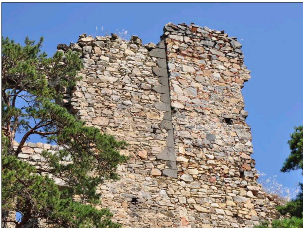
Obr. 93: Helfenburk, mělká kapsa šikmé, nejspíše provizorní vzpěry pod vstupem do 1. patra západní obytné části z nádvoří. Kapsa je tak mělká, že se samotná vzpěra nemohla bez zatížení shora udržet ve zdivu (srov. obr. 66 – šipka), stav 2017.
