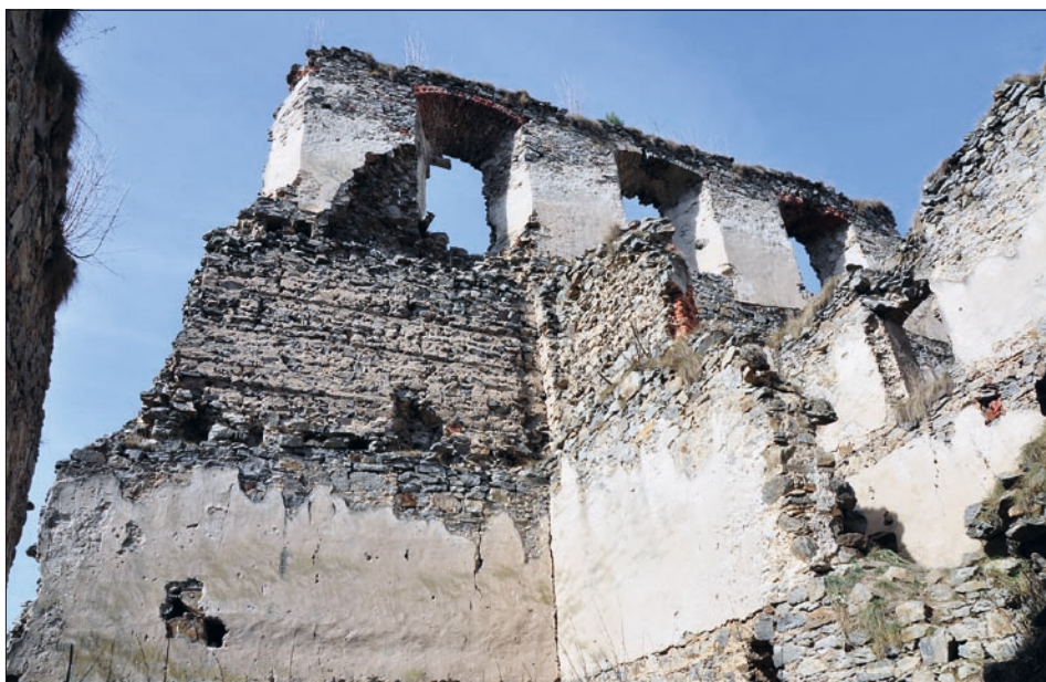
Obr. 44: Dívčí Kámen, detailní pohled z nádvoří do jižního traktu západní obytné části paláce s otiskem výdřevy světnice ve 2. patře (srov. obr. 38 vlevo). V mezitraktové zdi vidíme zbytek cihelné špalety obsluhujícího otvoru kamen (9), stav 2011.
