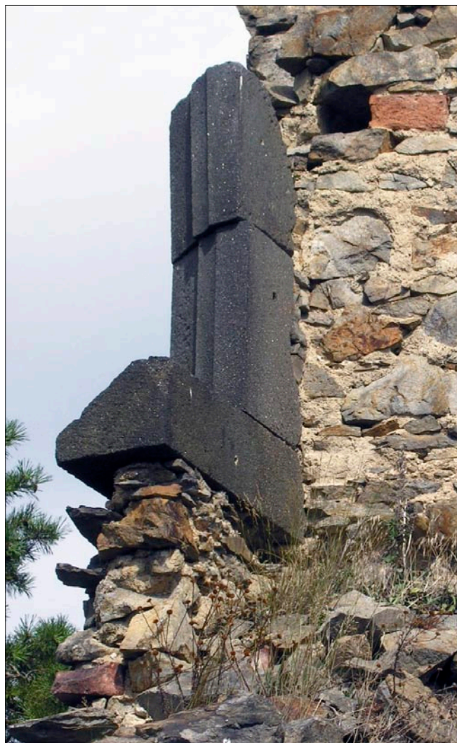
Obr. 87: Helfenburk, fragment ostění prostředního okna v západním průčelí paláce, osvětlujícího sál ve 2. patře. Na rozdíl od 1. patra nemělo ostění drážku pro okenici. Okenice zde byla zavěšená na hácích upevněných ve vnitřním líci ostění (dochované otvory) a při zavěšení zajištěná závorou zasouvanou do pochvy ve špaletě. Okno mělo postranní sedátka s dřevěnou deskou (srov. obr. 64c a 69 uprostřed nahore), stav 2008.
