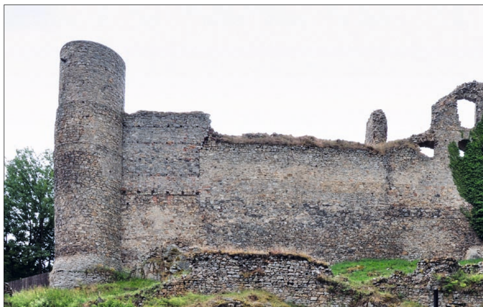
Obr. 9: Helfenburk, menší válcová věž a úsek hradby mezi ní a palácem, pohled od severu, z dolního hradu (srov. obr. 8). Horní část věže novodobá. S věží byl vystavěn krátký úsek hradby, zakončený cimbuřím se dvěma stínkami a jednou mezilehlou prolukou (vlevo dole). Teprve následně byla k této hradbě připojena podstatně vyšší a širší zeď, tvořící zároveň severní obvodovou zeď paláce (uprostřed a vpravo). Původní úsek hradby u věže byl poté výrazně zvýšen. V popředí relikty parkánové hradby, stav 2015.
