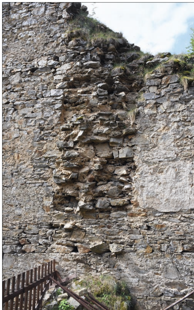
Obr. 18: Dívčí Kámen, nádvorní, severní strana jižní spojovací zdi (srov. obr. 21). Dole šikmo skloněné vrstvy zdiva, výše vodorovné. Šipkou označeno vnitřní ústí výlevky (srov. obr. 21/4). Vpravo stopy návaznosti západní nádvorní zdi (obr. 19), od ní vpravo dole ostění okénka do jižního sklepa (obr. 34). Vlevo východní nádvorní zeď, nad ní několik vázacích kamenů z doby po zvýšení spojovací zdi (obr. 21/17, 52), stav 2024.
