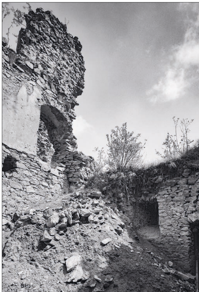
Obr. 45: Dívčí Kámen, detail dnes již zaniklé části zdi mezi středním a jižním traktem západní obytné části paláce, pohled z jižní místnosti přízemí. Vpravo nádvoří zeď s dosud dochovaným okénkem (23; obr. 34). Vlevo průchod v 1. patře, nahoře otisk výdřevy ve 2. patře a relikv východní špalety obslužného otvoru kamen, srov. s obr. 47 (foto Vl. Hyhlík, 1963, archiv NPÚ GnŘ, č. 96162).
