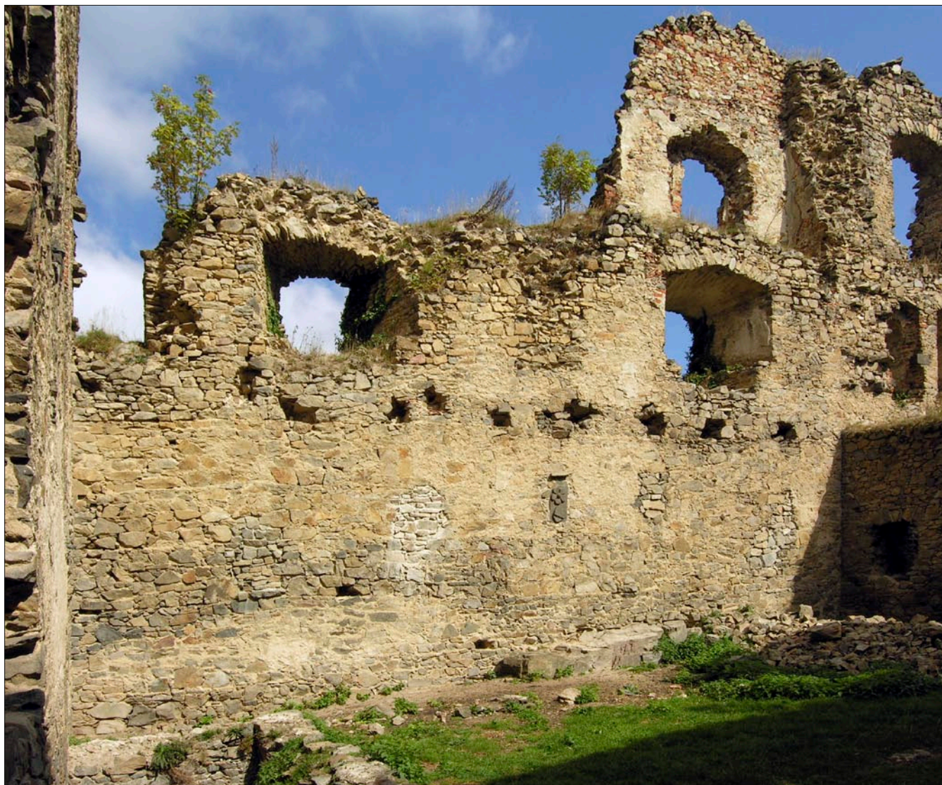
Obr. 91: Helfenburk, pohled z jihozápadního koutu nádvoří na severní spojovací zeď. Dole uprostřed druhotně umístěný kamenný znak (obr. 4), na ploše kolem najdeme stopy oprav destruktí a různých zásahů. Výše vodorovná řada druhotných otvorů, souvisejících s pozdějšími arkádami. Nad nimi zcela vlevo proluka po patrně původním prevetu, uprostřed dvě okna s postranními sedátky. Vpravo nad spojovací zdí tenčí zeď nástavby nejasného účelu, s jedním oknem se zaniklým ostěním. Vpravo od okna zbytky návaznosti horní části nádvorní zdi (níže v úrovni 1. patra tzv. šmorce, vpravo od nich vstup do prevetu ve východní obytné části paláce), stav 2008.
