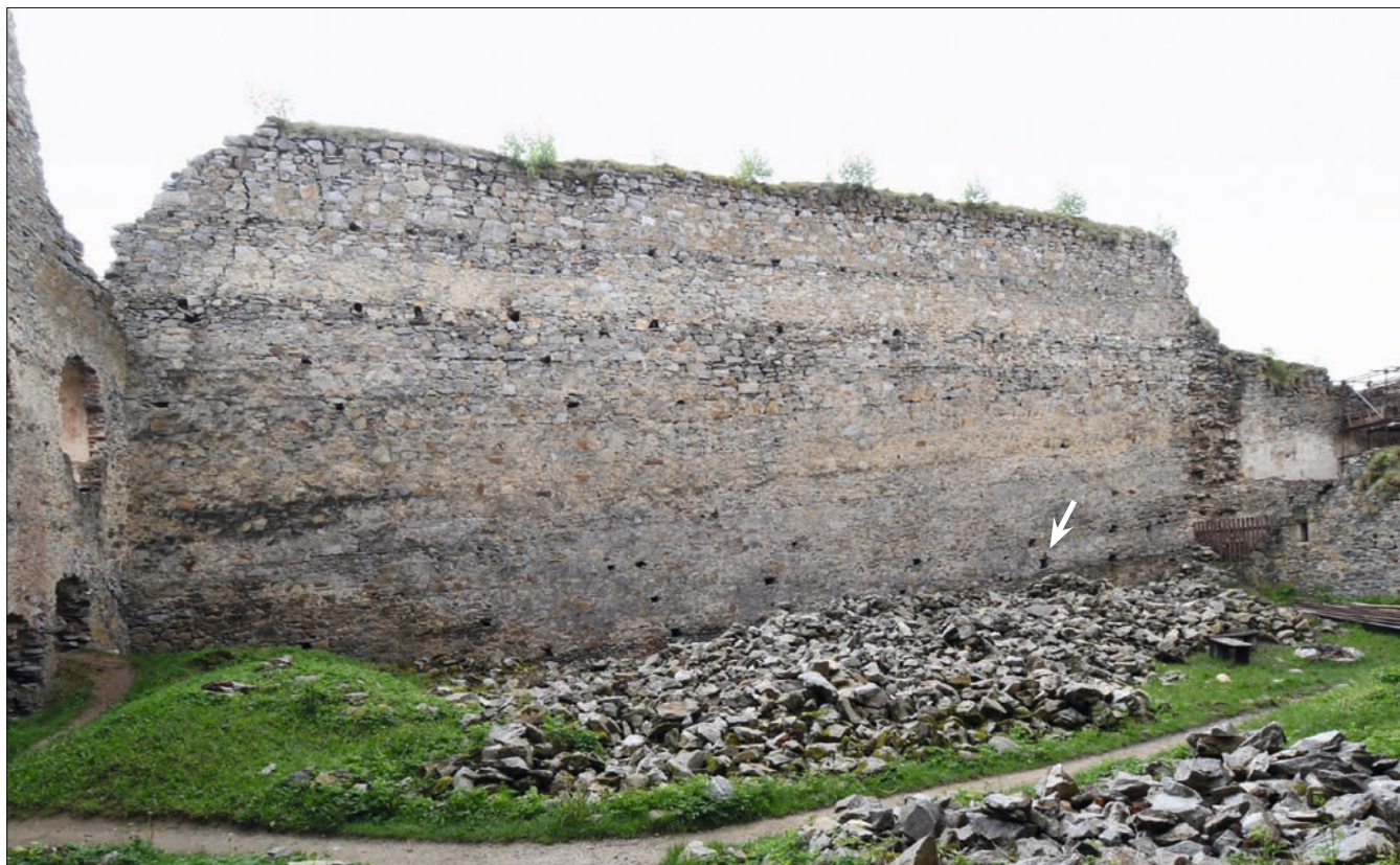
Obr. 18: Dívčí Kámen, nádvorní, severní strana jižní spojovací zdi (srov. obr. 21). Dole šikmo skloněné vrstvy zdiva, výše vodorovné. Šipkou označeno vnitřní ústí výlevky (srov. obr. 21/4). Vpravo stopy návaznosti západní nádvorní zdi (obr. 19), od ní vpravo dole ostění okénka do jižního sklepa (obr. 34). Vlevo východní nádvorní zeď, nad ní několik vázacích kamenů z doby po zvýšení spojovací zdi (obr. 21/17, 52), stav 2024.
