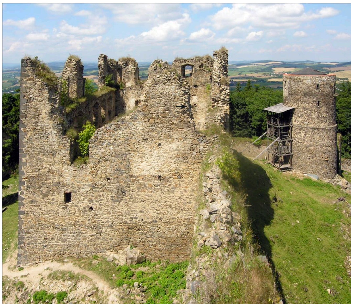
Obr. 96: Helfenburk, východní průčelí paláce v pohledu z menší válcové věže. Vpravo v pozadí větší válcová věž. Průčelí paláce je pod oknem 1. patra a vpravo od něj částečně přezděné. Upravené je také drobné okénko přízemí. Na vyvýšeném bloku zdiva vpravo od okna lze rozeznat část špalety jednoho z oken sálu a předstupující lomové kameny, které jsou zřejmě pozůstatkem mírně předsazené chodbičky v tloušťce zdiva k prevetu na severní fasádě (označeno šipkou). Vpravo na „řezu“ severní obvodovou zdí paláce se dochoval fragment špalety zaniklého okna v 2. patře. Vlevo uvnitř paláce najdeme zejména korunu jižní spojovací zdi se stojkou sedlového portálu do východního sálu, stav 2010.
