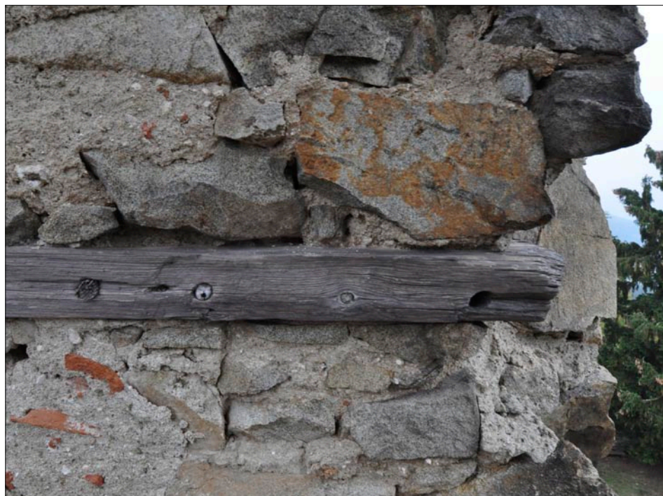
Obr. 103: Helfenburk, detail jedné z lišt deštění (srov. obr. 102) s otvory a zbytky dřevěných upevňovacích kolíků, stav 2015.
