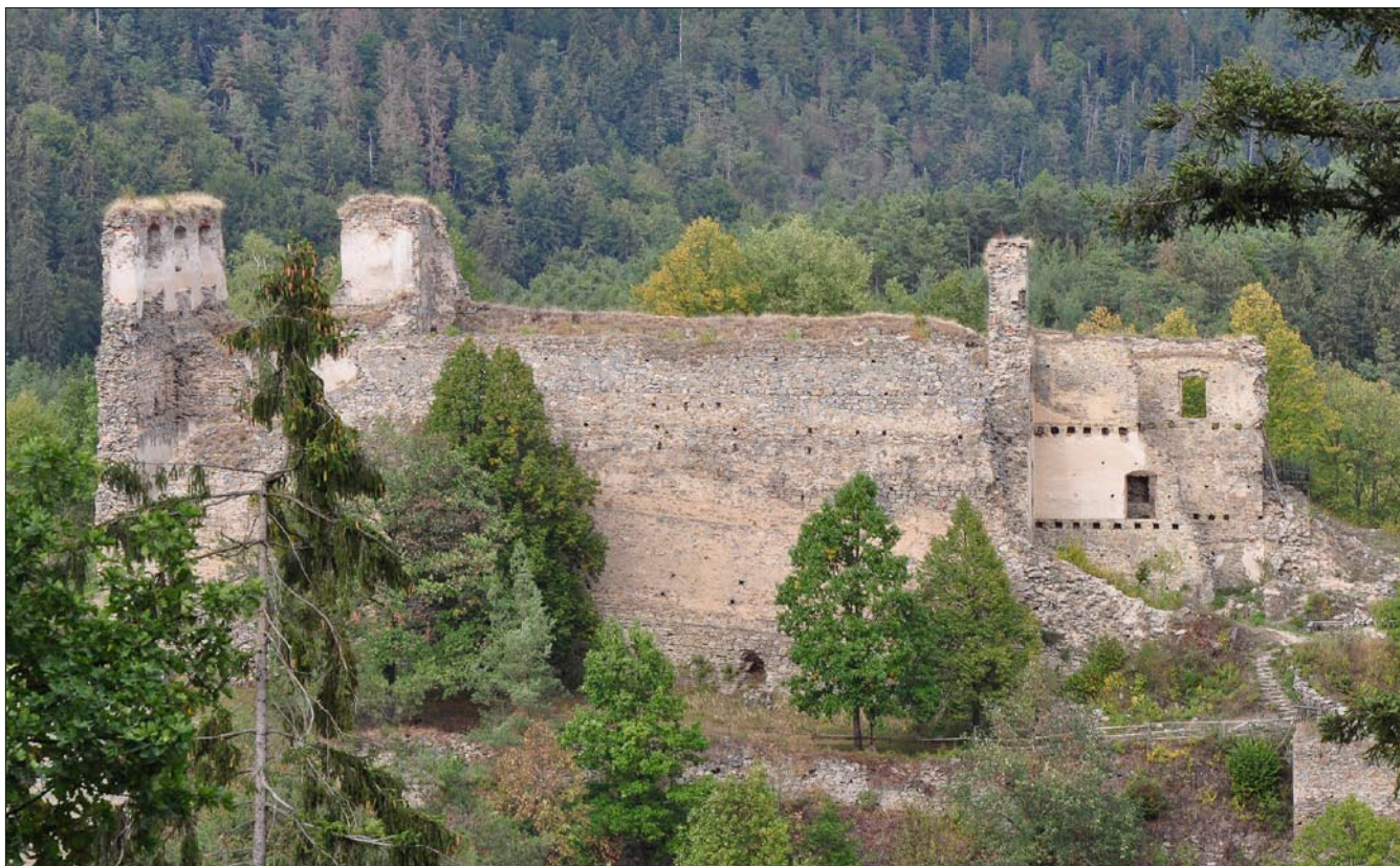
Obr. 17: Dívčí Kámen, dnešní pohled na palác od jihu umožňuje oproti snímku z roku 1963 (srov. obr. 2) nahlédnout do zbytků východní obytné části, s vodorovnými řadami stropních trámů. V horních úrovních stejné části stavby ubýly partie zdiva, také zanikly zbytky předprsně severní spojovací zdi. Dobře jsou čitelné otvory po nosnících předsazeného ochozu na jižní zdi (srov. obr. 20). Před palácem vyrostly stromy, které mohou ohrozit stabilitu a soudržnost zdiva, stav 2015.
