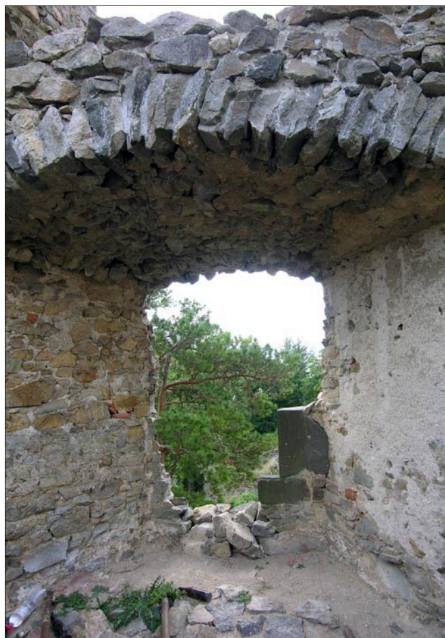
Obr. 72: Helfenburk, fragment ostění v 1. patře jižního průčelí západní obytné části. Ostění v širším prostoru okna ukazuje, že světlá šířka otvoru byla poměrně malá. Pozoruhodná je absence stop po upevnění okenice i pochvy po závoře ve špaletách. Chybí také postranní sedátka (srov. obr. 63b vpravo), stav 2008.
