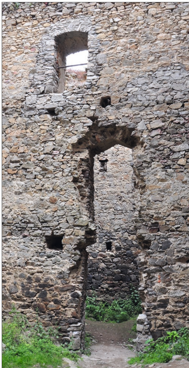
Obr. 12a, b: Helfenburk, porovnání průchodu v 1. patře mezitraktové zdi západní obytné části paláce, pohled z jižní místnosti, stav 2008 a 2015 (srov. obr. 69). Přes zánik ostění měl otvor velkou vypovídací schopnost, která se rasančně snížila způsobem jeho stavebního zajištění s využitím cementové malty (na druhém snímku nahoře). Pod průchodem v 1. patře otvory stejného účelu v úrovni přízemí a sklepa, zatím bez zajištění.
