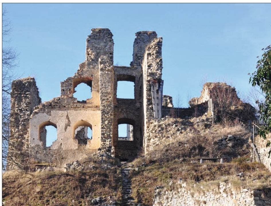
Obr. 54: Dívčí Kámen, celkový pohled na palácové jádro od východu. Destrukce východní partie stavby otevřela pohled do interiéru. Uprostřed úzký trakt průjezdu se třemi velkými okny směrem do nádvoří, vlevo interiérová stěna nádvorní zdi jižního traktu s omítkou, zřetelně přiložená na spáru k obvodové zdi (zcela vlevo), upravo podstatně méně dochovaný severní trakt (srov. obr. 53), stav 2017.
