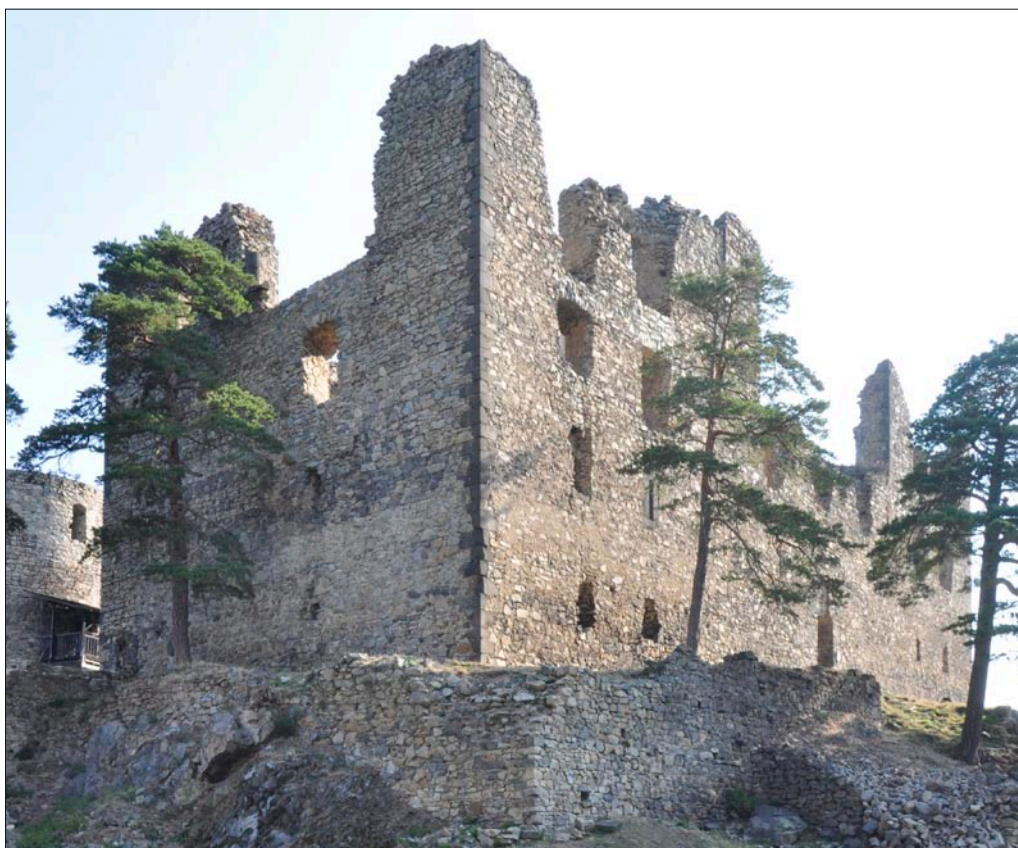
Obr. 59: Dívčí Kámen, pohled od jihu na relikt severní špalety otvoru brány do paláce (srov. obr. 57 vpravo a 17 vpravo). Vnější nároží s portálem brány zaniklo, vnitřní nároží je svázáno původními kvádry (24). Na toto nároží zleva přiléhá stěna průjezdu s výběhem stlačené valené klenby a zbytkem plošné omítky. Skutečnost, že stěna není v půdorysu odsazena od armovaného nároží, napovídá jejímu pozdějšímu vzniku. V celé výšce snímku je vidět, že boční zeď průjezdu (vlevo) byla na spáru přiložená k obvodové zdi paláce (uprostřed, srov. obr. 57), stav 2024.
