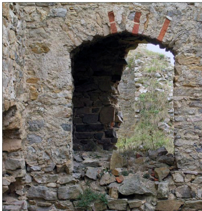
Obr. 71: Helfenburk, obslužný otvor kamen v 1. patře západního obytného dílu paláce (srov. obr. 70). Kamna v popředí zanikla beze stop. Za otvorem, jehož horní část musela sloužit také k odvodu kouře z kamen, je dutina dolní části komína. Za ní se otvírá průhled menším otvorem do nádvoří, který byl přístupný z pavlače (srov. obr. 65), stav 2008.
