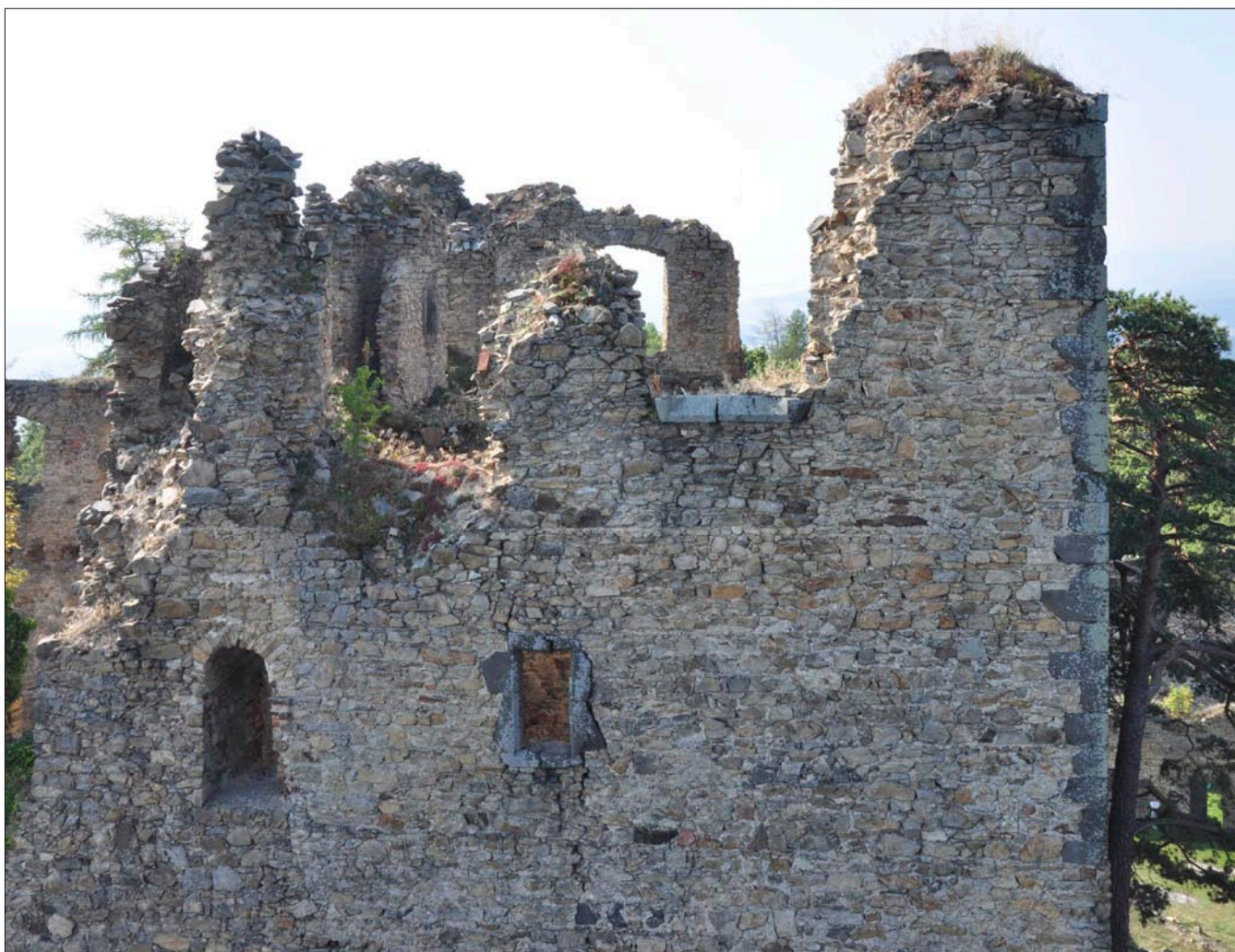
Obr. 82: Helfenburk, pohled z koruny velké válcové věže na horní partii západní obytné části paláce. Dole otvory 1. patra – vlevo vchod do zaniklého arkýře prevetu (zdívo vlevo od otvoru a pod ním přezděné), vpravo okno, původně s mříží (srov. obr. 83). Ve 2. patře vlevo chodbička do prevetu v dnes zříceném nároží. Průhledem na místě okna v popředí vidíme část nádvorní zdi sálu se skříňkou s uzavíratelným ostěním (obr. 75), vlevo od skříňky dutina komína společného krbu a kamnům v 1. patře. Pravě ze dvou oken v popředí si uchovalo tesaný parapetní díl ostění, prokazující absenci svislého středního prutu (obr. 84). V průhledu stejným oknem vidíme dvě nestejně dochovaná okna západní strany sálu, stav 2016.
