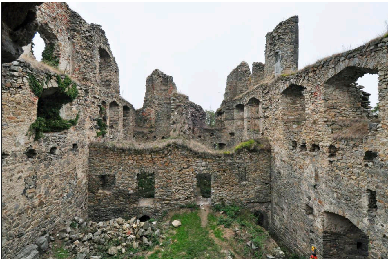
Obr. 97: Helfenburk, celkový pohled přes nádvoří na východní obytnou část paláce. Uprostřed nádvoří zeď, dochovaná jen v rozsahu přízemí. Před ní vlevo a vpravo šije ke vchodům do sklepů. Vpravo v patře okna s lištami někdejšího deštění (srov. obr. 101–103). Vpravo dole vchod do nádvoří od jihu, stav 2015.
