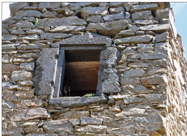
Obr. 75: Helfenburk, skříňka ve východní zdi 2. patra západní obytné části (srov. obr. 70). Na vnějším obvodu drážka a stopy závěsů pro dvířka, uvnitř zborcený prkenný překlad. Vpravo šplateta okna, stav 2017.
