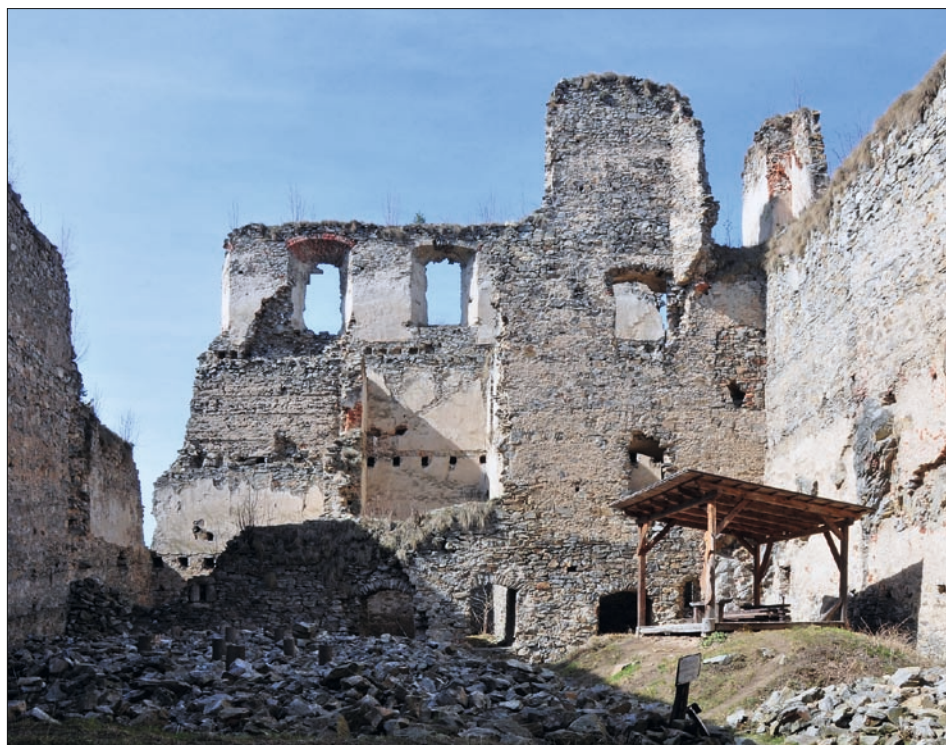
Obr. 32: Dívčí Kámen, pohled z nádvoří na západní obytnou část paláce (srov. obr. 31 a 33). Vpravo nejlépe dochovaný severní trakt s předstupujícím zbytkem arkýře kaple (11). Pod ním zazděný původní vchod z ochozu severní spojovací zdi do 2. patra (7). Nádvorní zeď středního a jižního traktu nad úrovní přízemí zanikla. V 2. patře jižního traktu zbytek dřevem zateplené světnice (8), obslužný otvor jejích kamen (9), nahoře dvě západní okna sálu (10), stav 2024.
