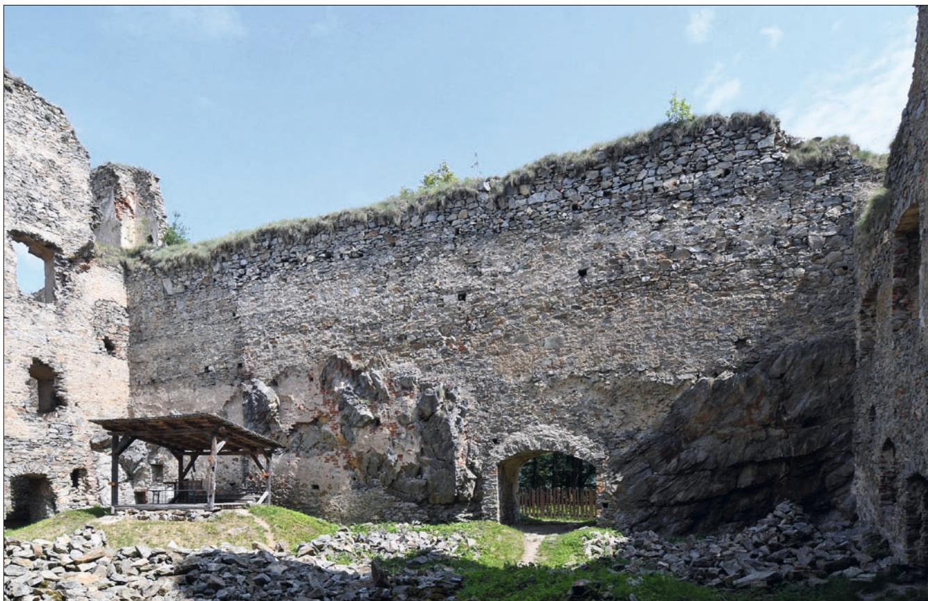
Obr. 28: Dívčí Kámen, celkový pohled z nádvoří na severní spojovací zeď (srov. obr. 23). Dole uprostřed dodatečný průraz do severního parkánu. Nerovnosti líce v sousedství průrazu podporují závěr o dodatečném vzniku otvoru. Po stranách dochované části rostlé skály, využité při stavbě zdi. Vlevo (nad dřevěným přístřeškem) je patrný mírný zlom v průběhu líce. Vlevo v nádvoří zdi západní obytné části zazděný otvor (7), patrně původní vchod z ochozu spojovací zdi (obr. 35). Otvor byl nejspíše zazděn při prvním zvýšení této zdi. V pozadí nad koutem styku spojovací zdi a průčelí obytné části relikv kaple s koutem jejího interiéru, kde lze rozeznat zbytky cihelné klenby (12), stav 2024.
