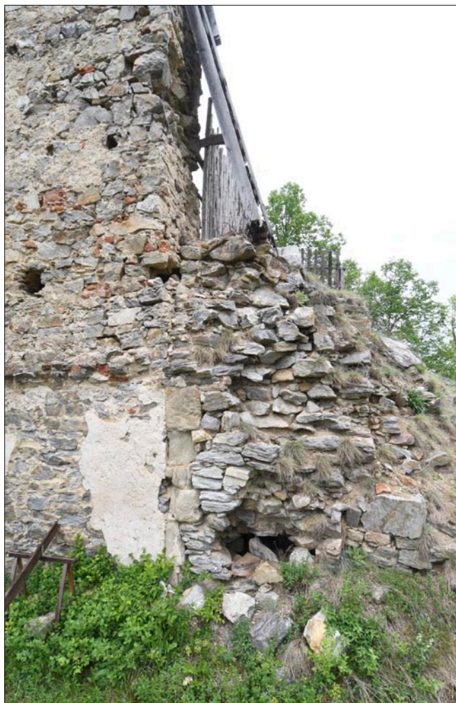
Obr. 59: Dívčí Kámen, pohled od jihu na relikt severní špalety otvoru brány do paláce (srov. obr. 57 vpravo a 17 vpravo). Vnější nároží s portálem brány zaniklo, vnitřní nároží je svázáno původními kvádry (24). Na toto nároží zleva přiléhá stěna průjezdu s výběhem stlačené valené klenby a zbytkem plošné omítky. Skutečnost, že stěna není v půdorysu odsazena od armovaného nároží, napovídá jejímu pozdějšímu vzniku. V celé výšce snímku je vidět, že boční zeď průjezdu (vlevo) byla na spáru přiložená k obvodové zdi paláce (uprostřed, srov. obr. 57), stav 2024.
