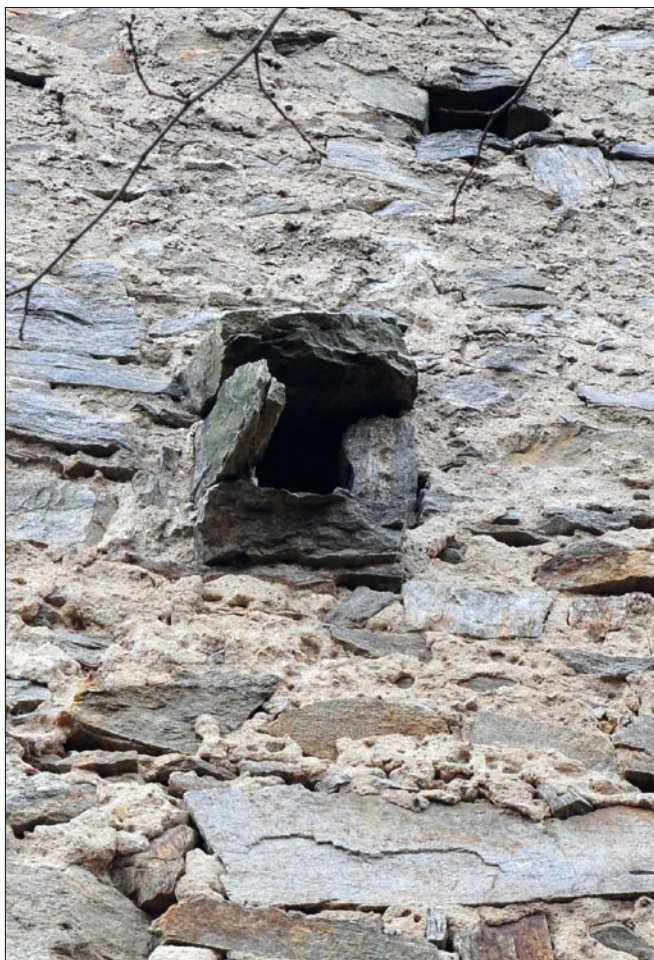
Obr. 24: Dívčí Kámen, chrič (4) v jižní spojovací zdi, podhled z parkánu. Pravý a dolní kámen tvořící chrič jsou ураžené, stav 2013.
