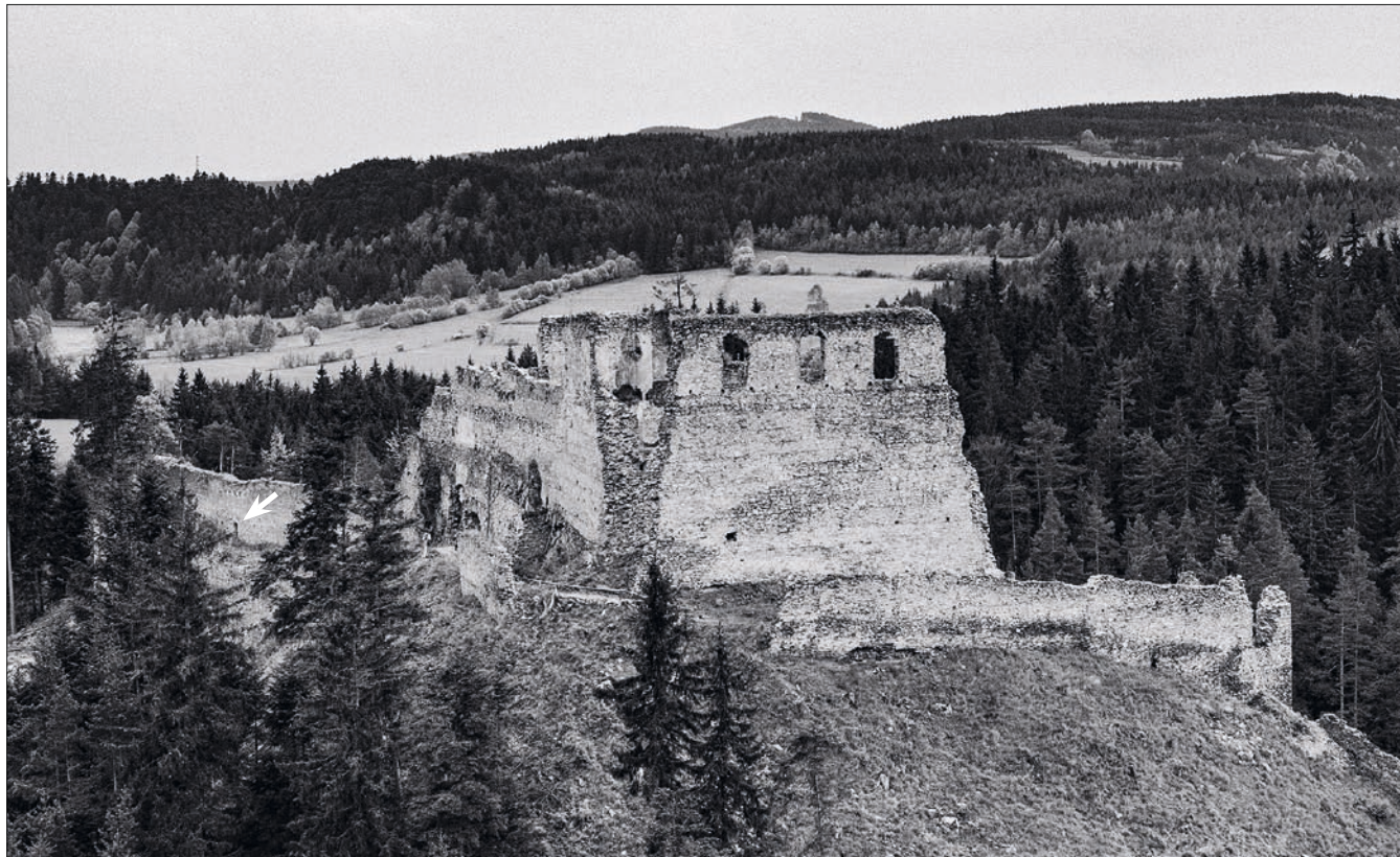
Obr. 30a: Dívčí Kámen, palác od severozápadu. Vpravo západní průčelí s třemi okny sálu a zřícenými nárožími (srov. obr. 29), vlevo severní průčelí, v dolní polovině zvenku zesílené i jinak upravované (srov. obr. 25). Dole uprostřed tohoto průčelí, nad úsekem parkánové zdi, vyčnívá horní část průchodu do parkánu (3). Vlevo od paláce hradba běžící po skalním hřebeni k válcové věži (není vidět). Uprostřed hradby (šipka) jedna z branek, nad ní otvory po nosnících předpokládané sedlové věžice (foto Vl. Hyhlík, 1962, archiv NPÚ GnŘ, č. 96134).
