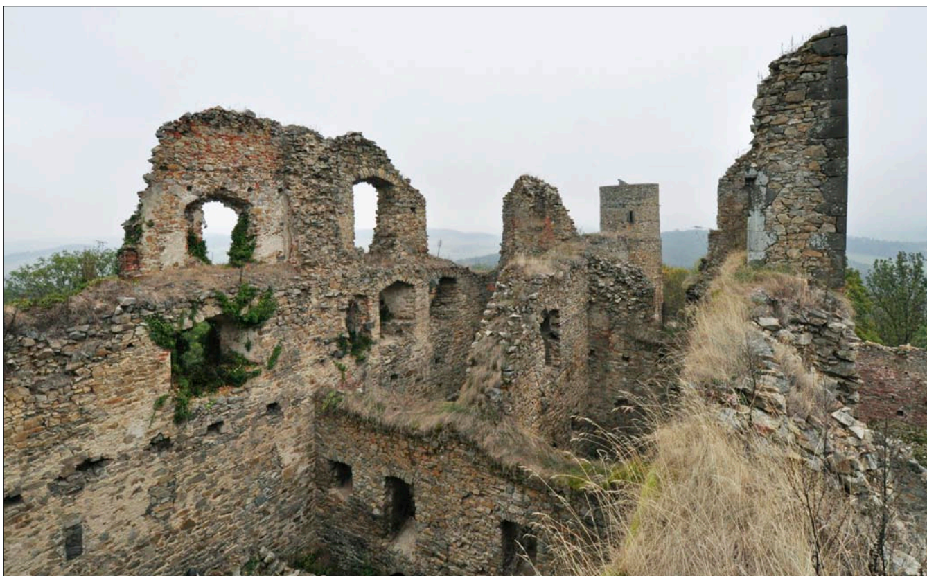
Obr. 98: Helfenburk, pohled z koruny západního konce jižní spojovací zdi na východní obytnou část paláce (srov. obr. 97). V popředí dole dochovaná přízemní část nádvoří zeď, nad ní mezitraktová zeď. Vpravo nad spojovací zdi torzo sedlového portálku do sálu v 2. patře. Vlevo nahoře severní zeď 2. patra, vlevo od ní zeď dodatečné nástavby (srov. obr. 91). V pozadí menší válcová věž, stav 2015.
