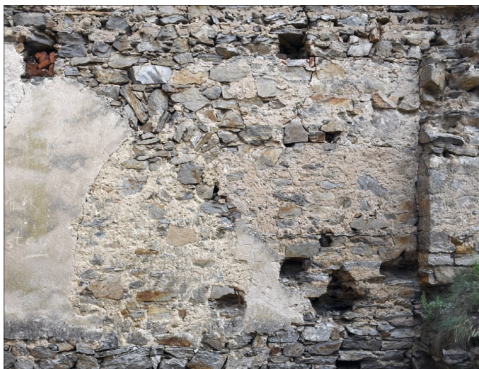
Obr. 42: Dívčí Kámen, detail severní stěny 1. patra středního traktu v západním dílu paláce (srov. obr. 40 a 41). Uprostřed (vpravo od plochy omítky) zazděný původní otvor s hrotitým záklenkem (6), vpravo část špalety okénka (5) v nádvorní zdi. Stav 2024.
