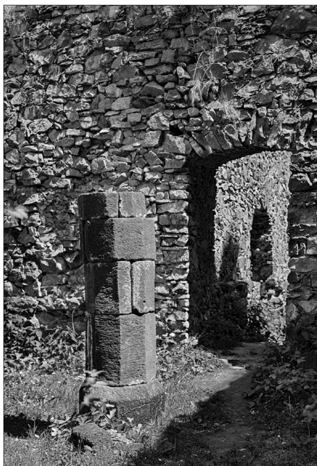
Obr. 13: Helfenburk, anastyloza části polygonálního sloupu arkády na nádvoří z fragmentů nalezených při výkopu. V pozadí vstup do jižní místnosti východní obytné části paláce. Dnes sloup neexistuje (foto V. Obereigner, 1963, archiv NPÚ GnŘ, č. 94979).
