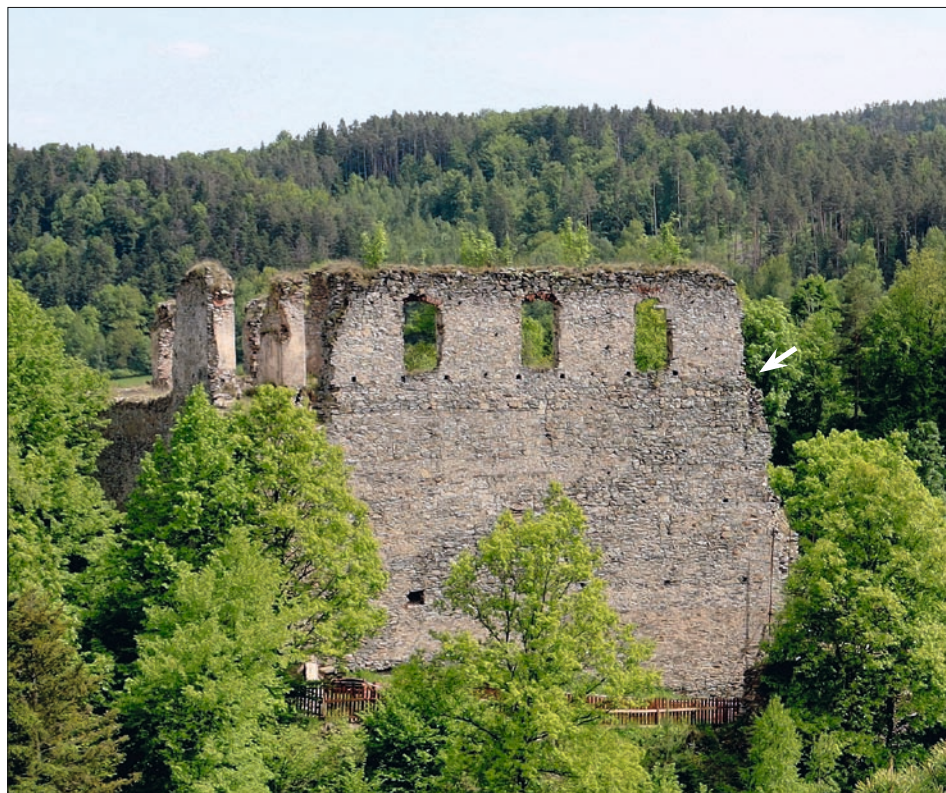
Obr. 29: Dívčí Kámen, západní průčelí paláce se třemi okny sálového prostoru 3. patra. Těsně pod okny probíhá vodorovná řada otvorů po nosnících zaniklého dřevěného ochozu. Zcela upravo se v této úrovni rýsuje poněkud šikmé nasazení lince zdiva horního patra (označeno šipkou, srov. obr. 2, 20, 21) (snímek J. Hansová, 2021).
