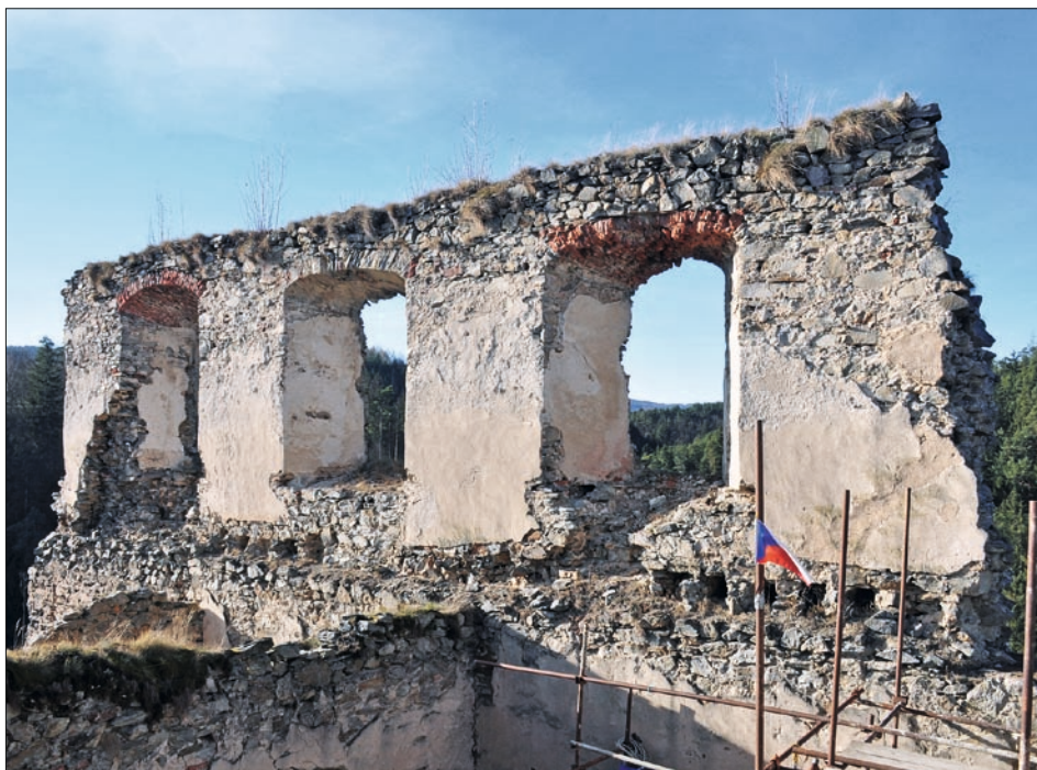
Obr. 48: Dívčí Kámen, pohled od kaplového arkýře na západní zeď paláce se třemi okny (srov. obr. 38 a 44), stav 2017.
